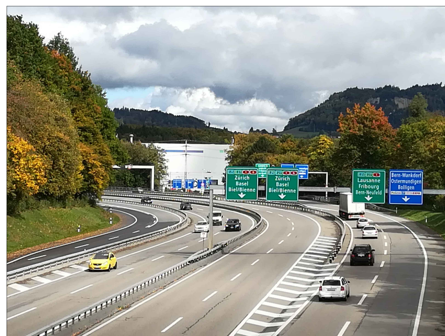
Franchissement principal : Autoroute A6 au niveau de l'échangeur Bern-Wankdorf
