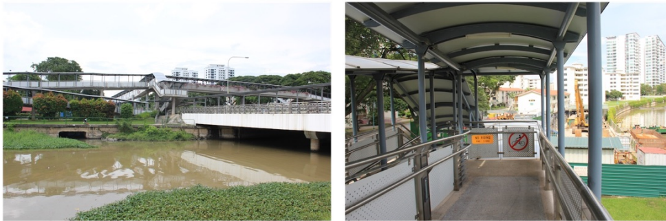
FIGURE 7.32 – Infrastructure pour piétons et cyclistes le long d'un cheminement de mobilité douce pour traverser la route : les cyclistes sont obligés de pousser leur vélo pour franchir l'obstacle
