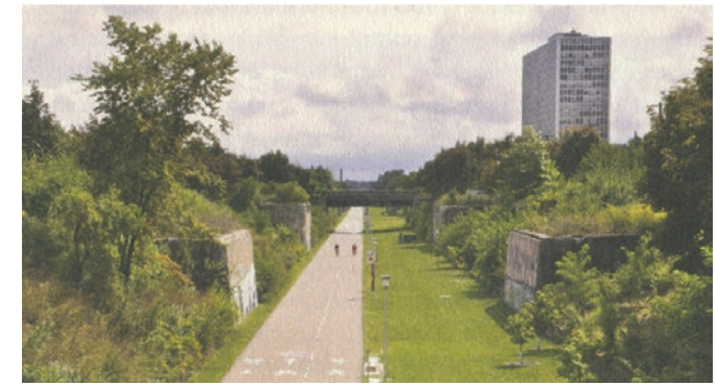
Piste cyclable sur une ancienne voie de chemin de fer IN: Recycler l'urbain, © J. Sordi
