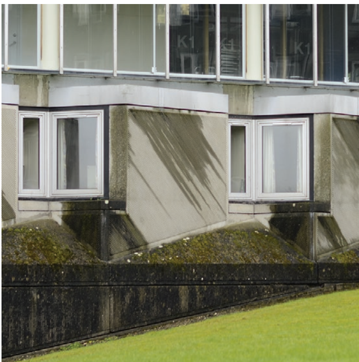
Les trainées d'eau sur les éléments préfabriqués © Clément Cattin
