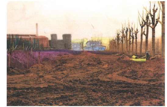
Photographie du sol pendant le chantier IN: Sub/Sur-urbanism, © Elizabeth Lennard
