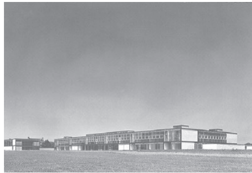
L'école depuis les champs IN: The charger Void: Architecture
