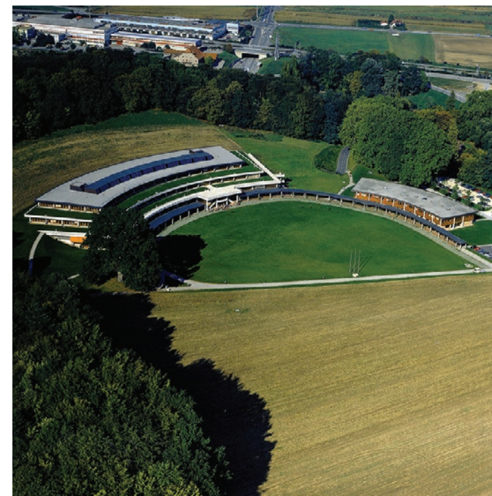
Centre administratif Lausanne-Vidy ETH Bildarchiv © Zsolt Somorjai
