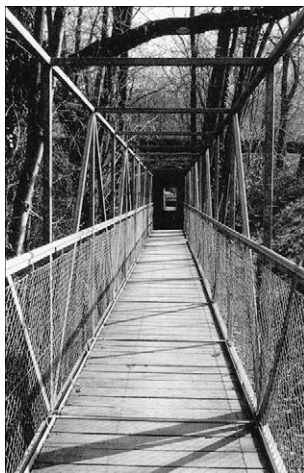
Georges Descombes, Parc de Lancy, pont-tunnel.
