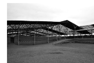
Toitures de protection, Chan Chan, 2017.
