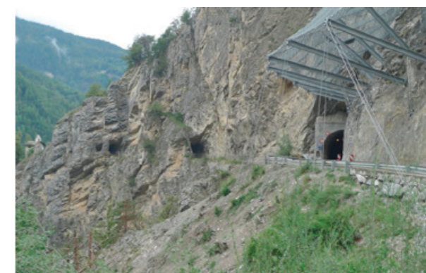
Fig. 19 - Tunnel actuel de la vallée, 2010.
