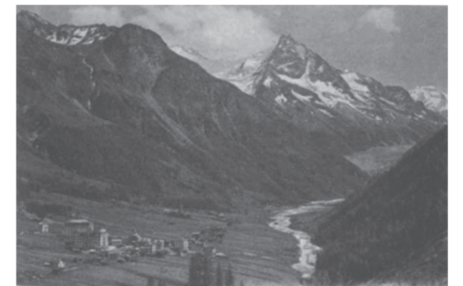
Fig. 53 - Construction de nouveaux hôtels.
