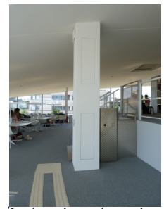
Intégration nécessaire des gaines techniques
