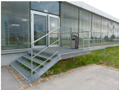
Sortie de secours inutilisable par les personnes handicapées
