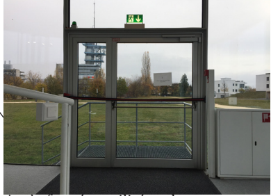
Accès fermé et utilisé seulement comme sortie de secours
