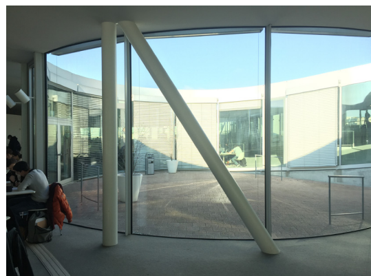
Eléments de contreventement visible dans le bâtiment
