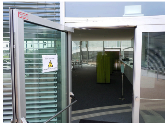
Sortie de secours du patio en «8» laissée ouverte
