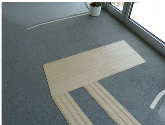
Bandes de guidage au sol qui amènent vers une sortie de secours pas utilisable par les handicapés
