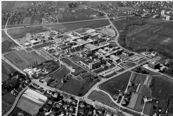
Campus EPFL, vue aérienne, 1987
