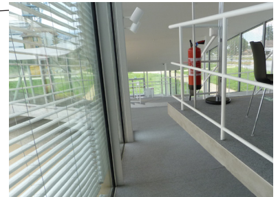
Passage en conflit avec la géométrie du bâtiment
