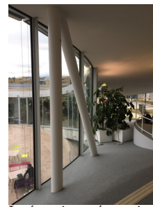
Intégration nécessaire du contreventement
