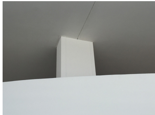
Gainages techniques qui rejoignent le plafond pour l'écoulement d'eau
