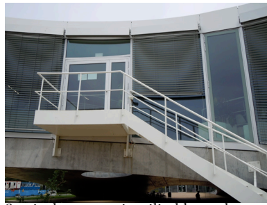
Sortie de secours inutilisable par les personnes handicapées
