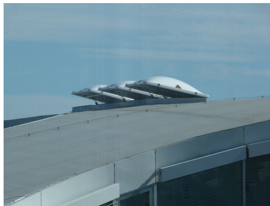
Ouvertures zénithales au-dessus de l'auditoire
