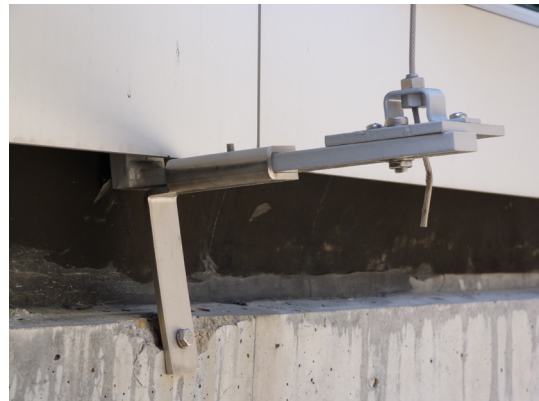
Détail de la partie inférieure des stores
