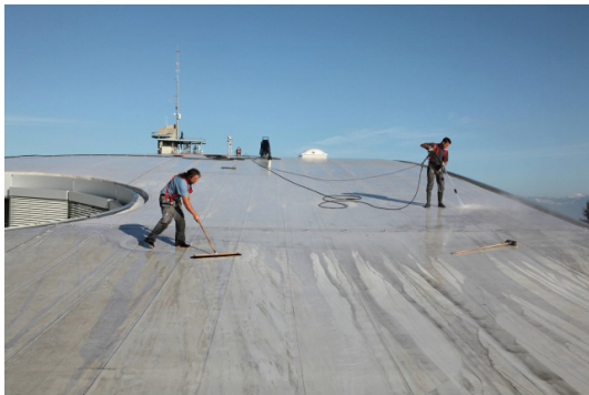
Nettoyage du toit, 2011 (© Alain Herzog)
