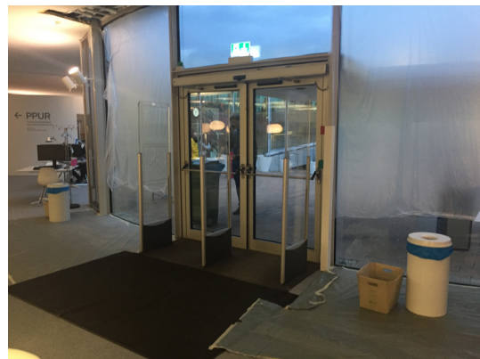
Nouvelle installation d'un système de contrôle pour permettre l'accès à la bibliothèque depuis l'extérieur
