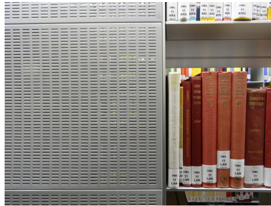
Système de ventilation mécanique intégré dans les étagères pour contrôler l'environnement intérieur
