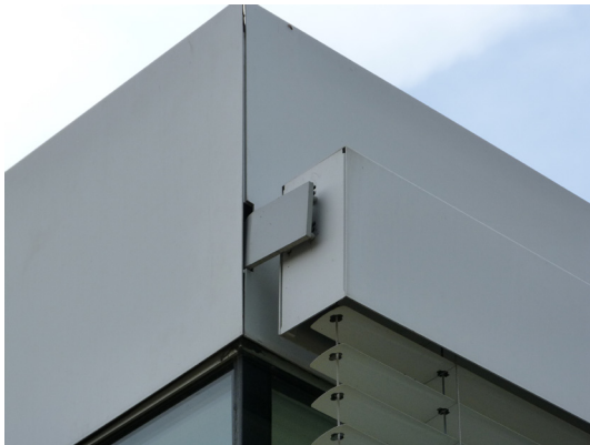
Détail de la partie supérieure des stores
