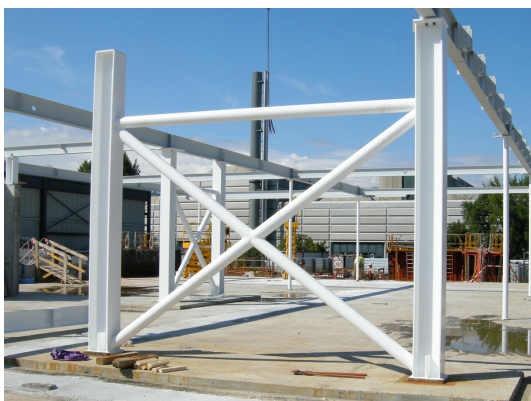
Intégration d'éléments de contreventement pendant le chantier
