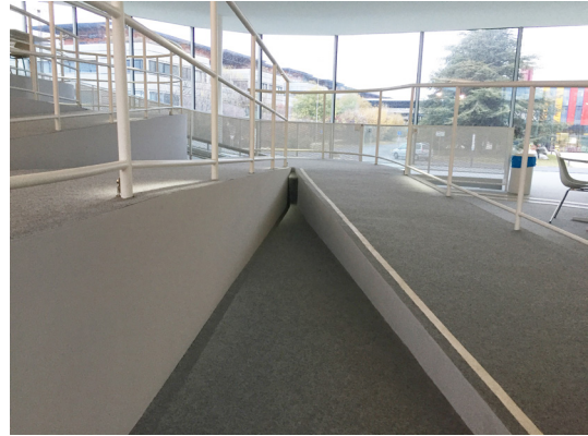
Espace «mort» causé par l'intégration des rampes
