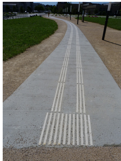
Dispositif de guidage au sol interrompu avant d'entrer dans le bâtiment
