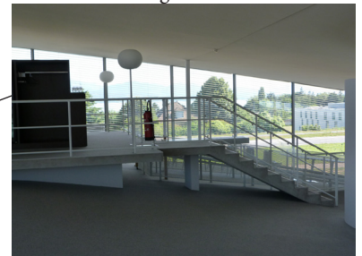
Eléments architecturaux en conflit avec l'utilisation du bâtiment
