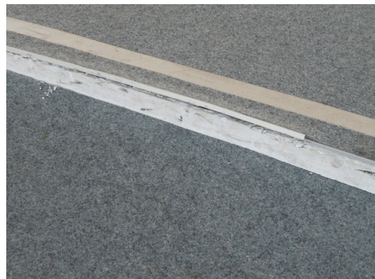
Finitions en plâtre très fragiles
