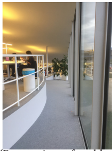
Passage inconfortable ou inutilisé
