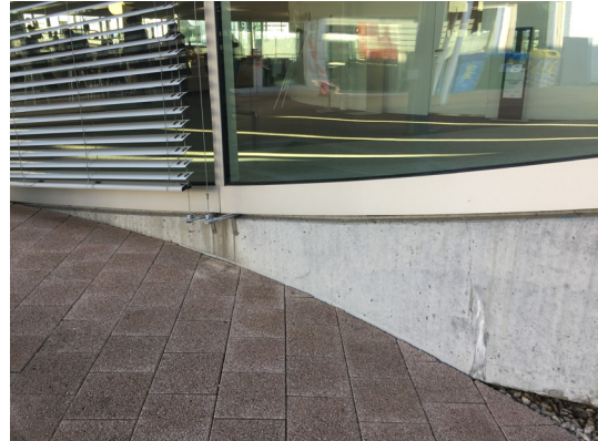
Liaison du sol extérieur avec la façade
