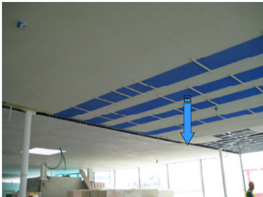
Mise en œuvre du plafond froid au-dessus de la zone de lecture ouest
