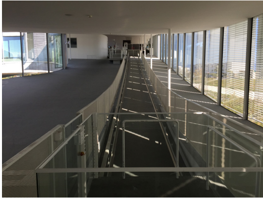
Ascenseur horizontal pour rejoindre le restaurant. L'espace à côté de la façade reste inexploité
