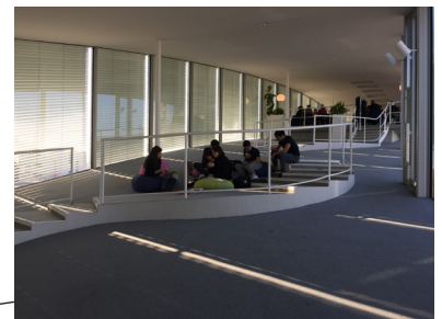
Obstruction du parcours par utilisation impropre des éléments architecturaux
