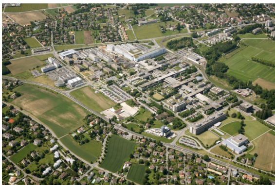
Campus EPFL, vue aérienne, 2007
