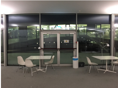
Sortie de secours obstruée par emplacement des tables de travail
