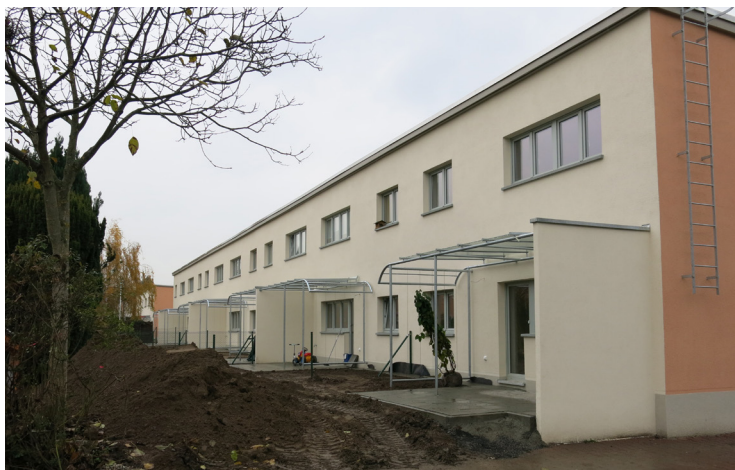
Figure 25. Façades Ouest des maisons individuelles de Westhausen, alors en restauration.
