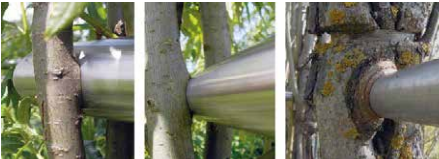
Ferdinand Ludwig, Développement des détails de connexion de la main courante du Baubotanischer Steg.
