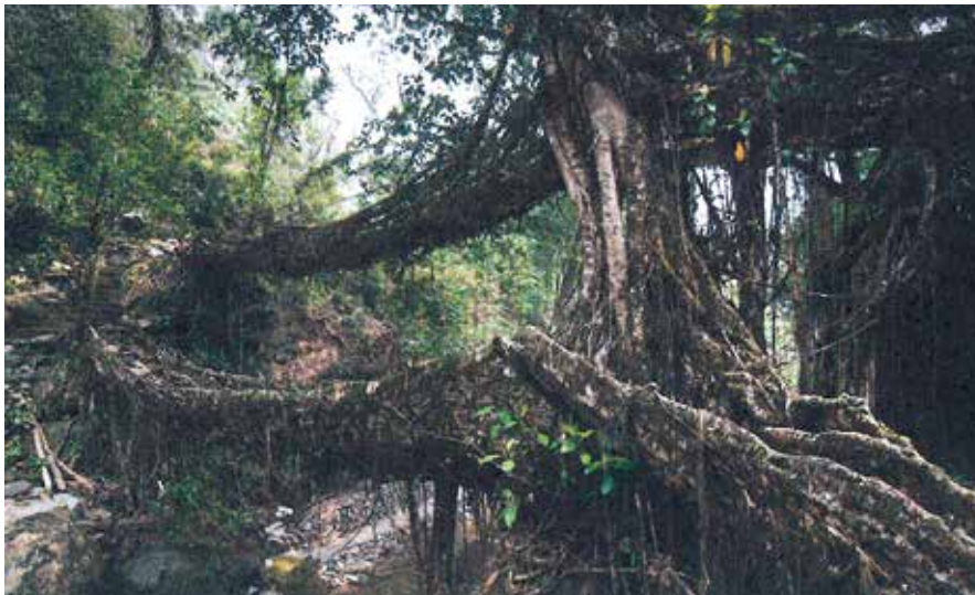
Pont vivant à 2 niveaux au-dessus de la rivière Umshiang.
