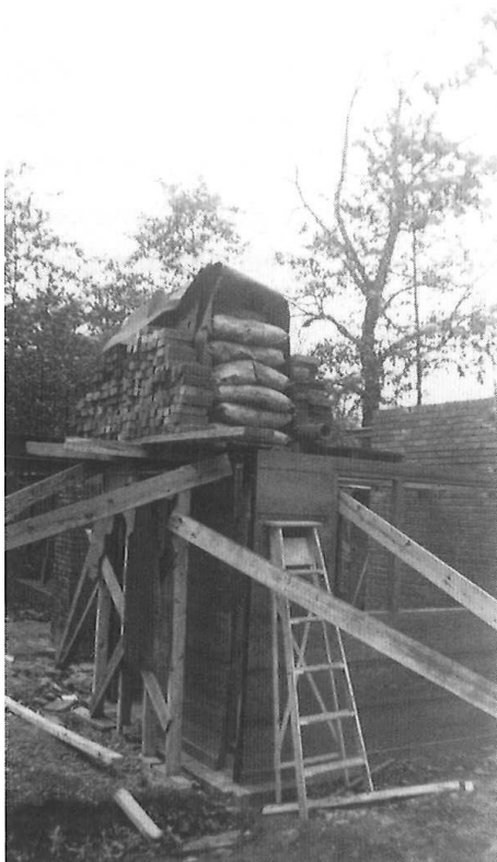
08. Test structurel sur site d'un assemblage de panneau multi-couche d'une maison usonienne, à l'image du test produit sur les colonnes de la Johnson Was HQ .
