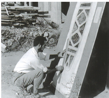
10. André Ravéreau exécutant un gabarit pour la réalisation de la fenêtre de l'abside de l'église sainte-Euphémie, en Grèce, 1955.
