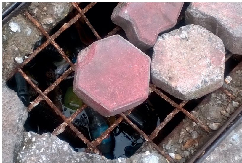
Figure 10 Bouche du réseau d'évacuation des eaux usées, Hanoi, 2017
