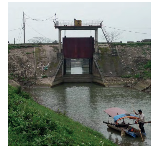
Figure 27 Ecluse du casier de Bac Nam Ha, province de Nam
