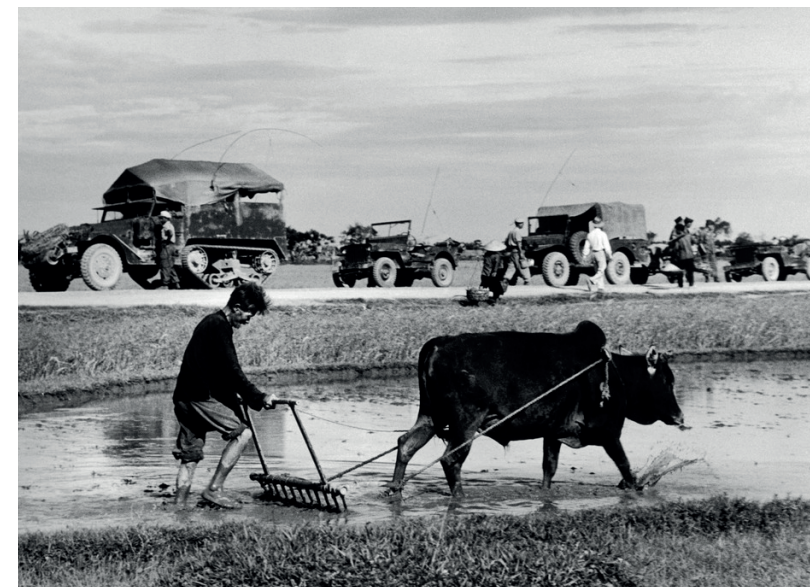
Figure 14 Convoi militaire français se dirigeant vers le Nord sur la route de Namdinh à Thaidinh (S-E), 1954
