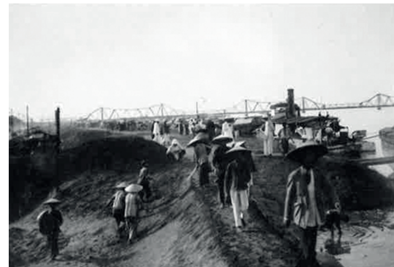
Figure 15 Construction traditionnelle de digue à Hanoi, 1932
