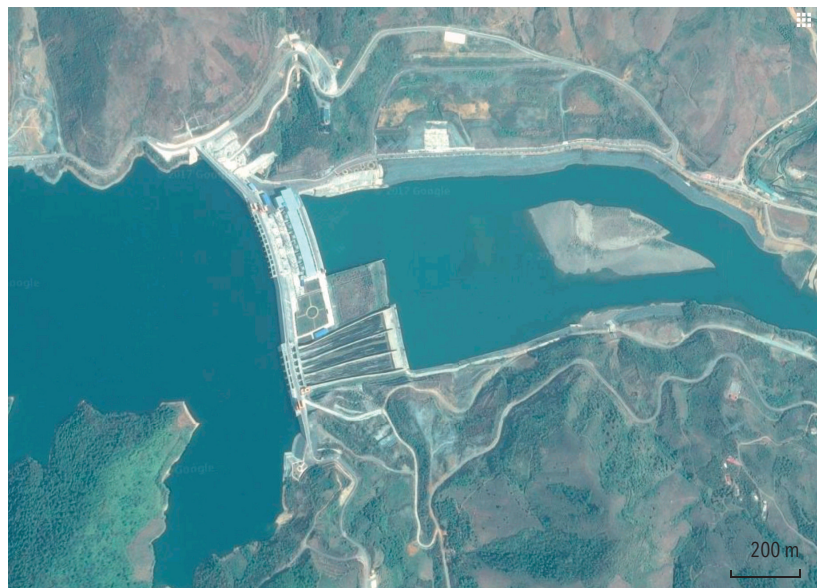
Figure 9 Barrage de Son La sur la rivière Đà, 6 turbines, 2400 W, achevé en 2012
