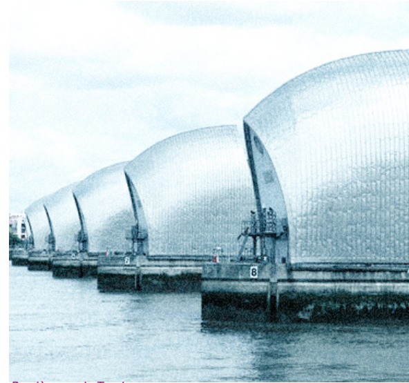
Barrière sur la Tamise Londres, Angleterre 1984
