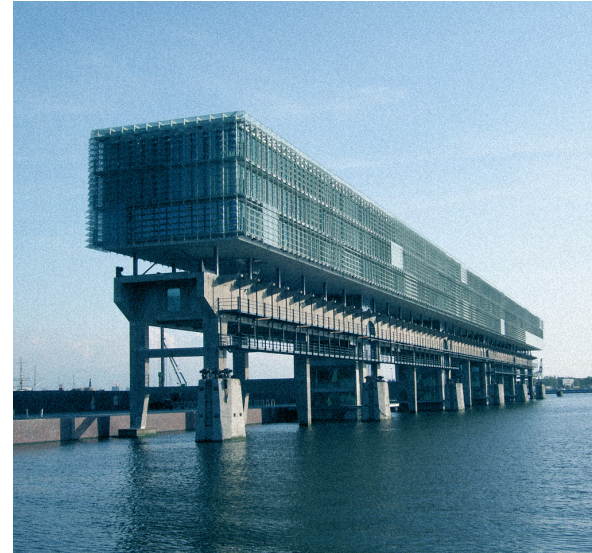
Kraanspoor Amsterdam, Pays-bas 2007 oth_architecten
