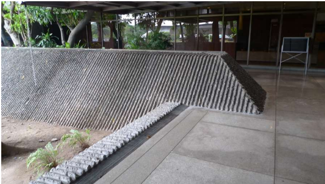
Leandro Locsin_Population Center (1972)_Makati Détail du socle en béton détachant le bâtiment du sol.
