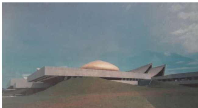
Leandro Locsin_ Istana Nurul Iman (1983)_Brunei Vue générale montrant l'intégration au site et maquette Source: VILLALON, PEREZ III (1996), photo Jean-Claude Girard
