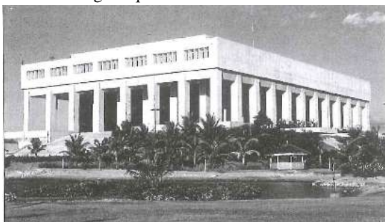
Froilan Hong_Manila Film Center_(1982)_Pasay Vue de l'entrée Source: LICO (2003)
