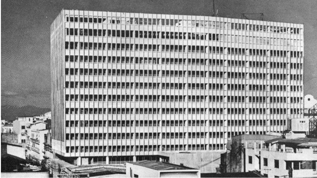
Carlos Arguelles_ DBP Building (1962) Façade principale avec les brise-soleils préfabriqués Source: www.esquimag.ph
