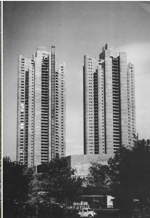
Paul Rudolph_Tracey Tower (1968)_New York Vue extérieure Source: Pinterst
