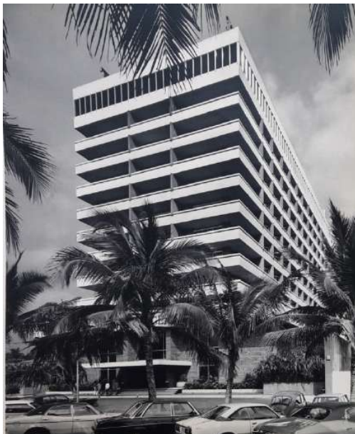
Leandro Locsin_Sheraton Philippines Hotel (1959)_Manila Vue de la rue
