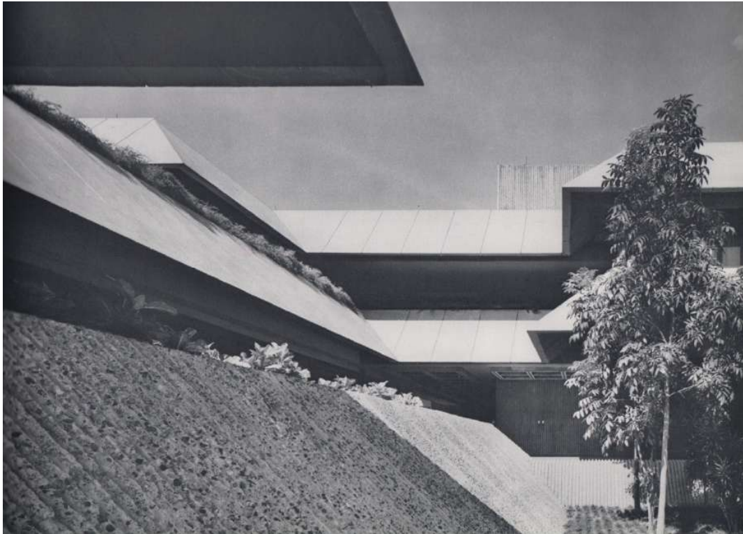
Leandro Locsin_Population Center (1972)_Makati Détail des façades Source: POLITES (1977), photo Akio Kawasumi
