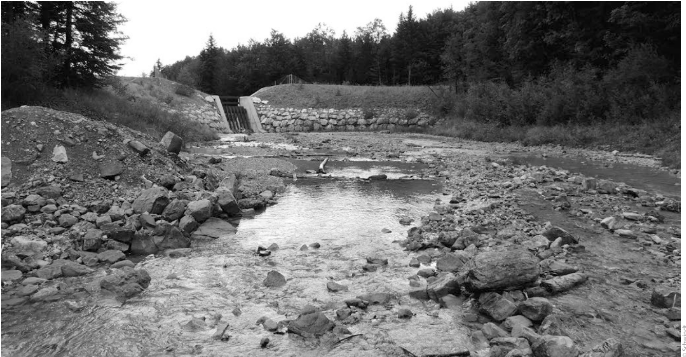
Bild 1: Geschiebesammler am Jenbach (Bayrische Voralpen) mit Blick vom Ablagerungsplatz in Richtung des Abschlussbauwerks
