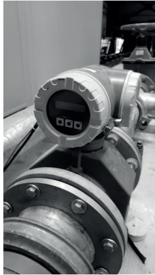
Figure 4.9 – ENDRES + HAUSER - PROMAG 50 W flowmeter
