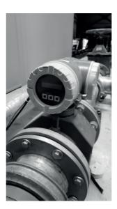
Figure 4.9 - ENDRES + HAUSER - PROMAG 50 W flowmeter
