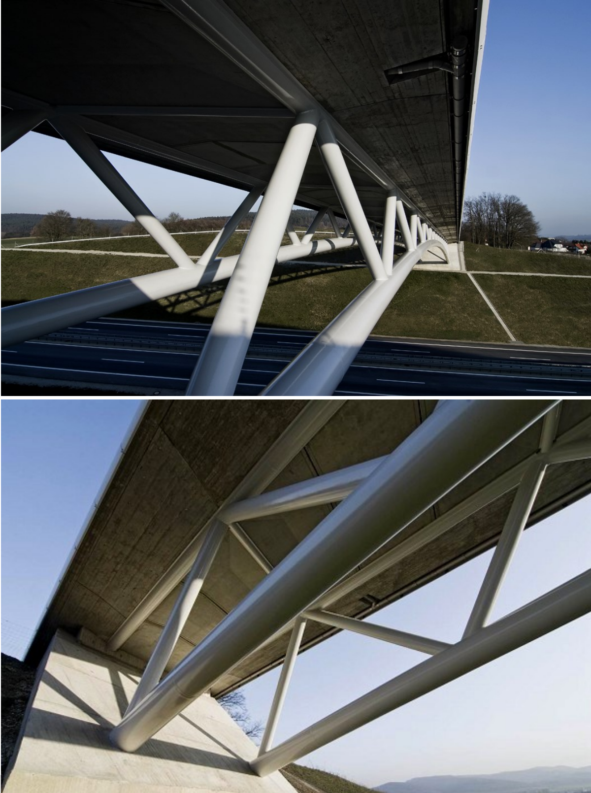
Figure 3. Autoroute A73, BW 67-1, pont en arc en treillis à grande ouverture, SSF Ingénieure (2008), http://www.ssf-ing.de/
