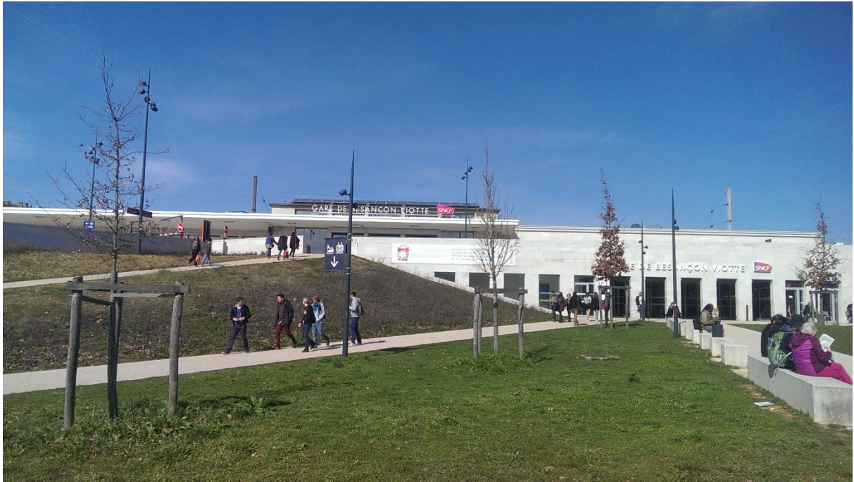
Figure 42 Entrée sud de la gare Viotte, à droite le souterrain, à gauche le Hall principal, 2017 (photo : Ville-Glasauer)
