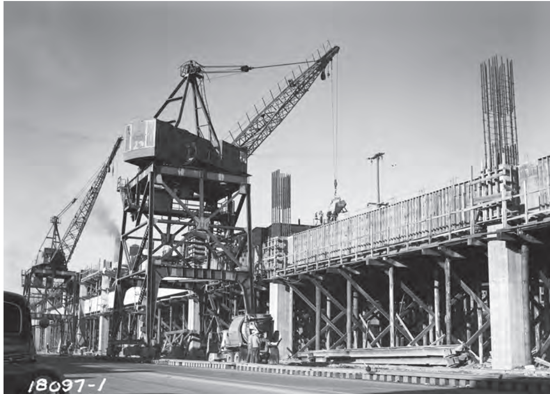
construction du viaduc le long de l'Alaskan Way, 1951
