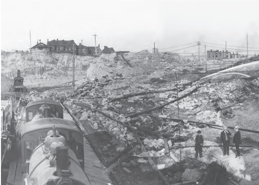
utilisation de la pression hydraulique pour casser la roche, 1907
