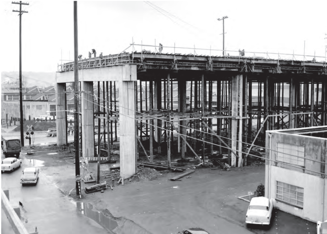
construction de l'extension sud du viaduc, 1959
