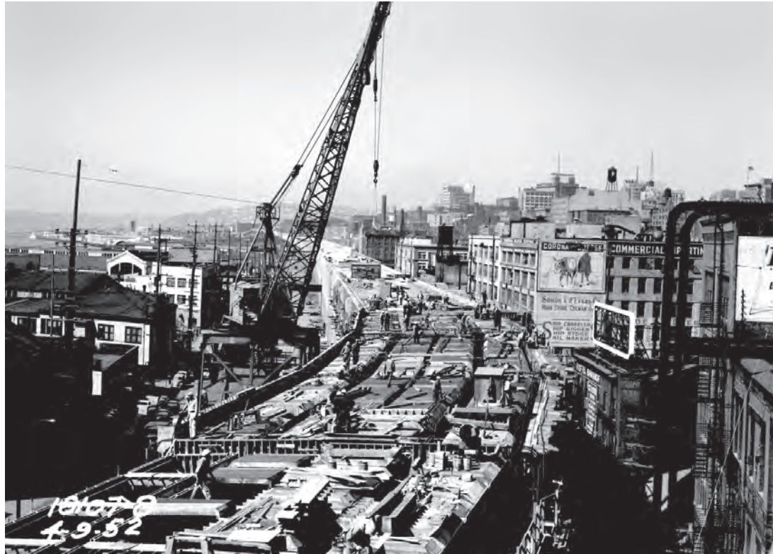
construction de l'Alaskan Way Viaduct, 1952
