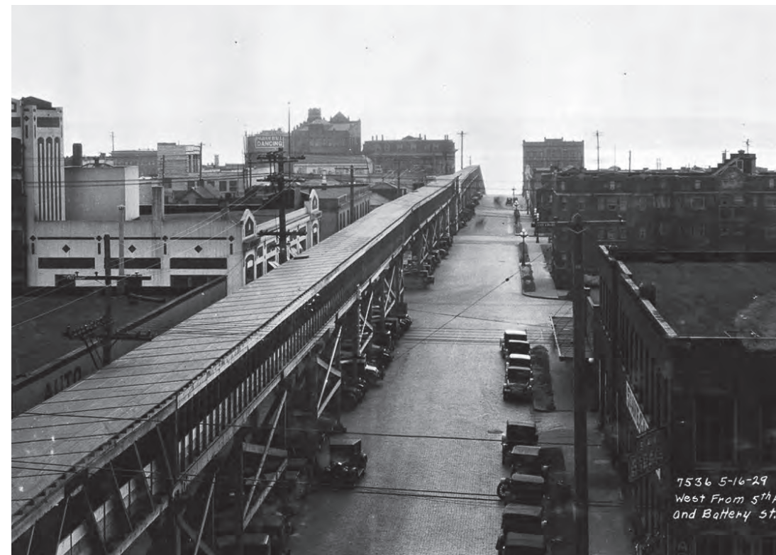
tapis pour le transport des gravas sur Battery Street, 1929
