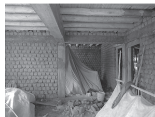
Une maison en construction à Shey révèle sa structure poteau-poutre
