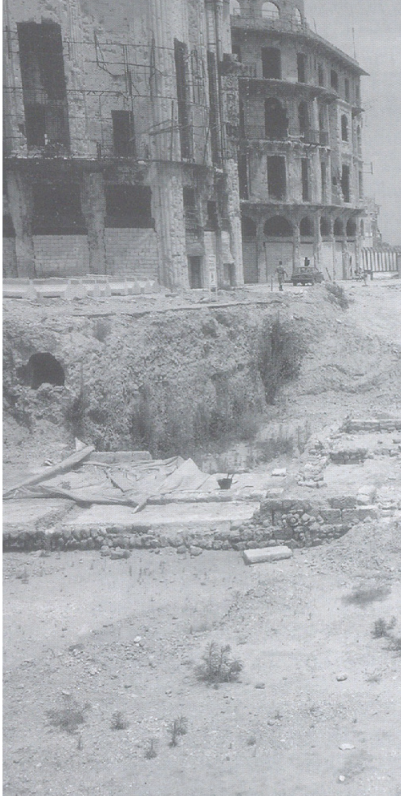
12. Image du nouveau Beyrouth sur les fondations de l'ancien
