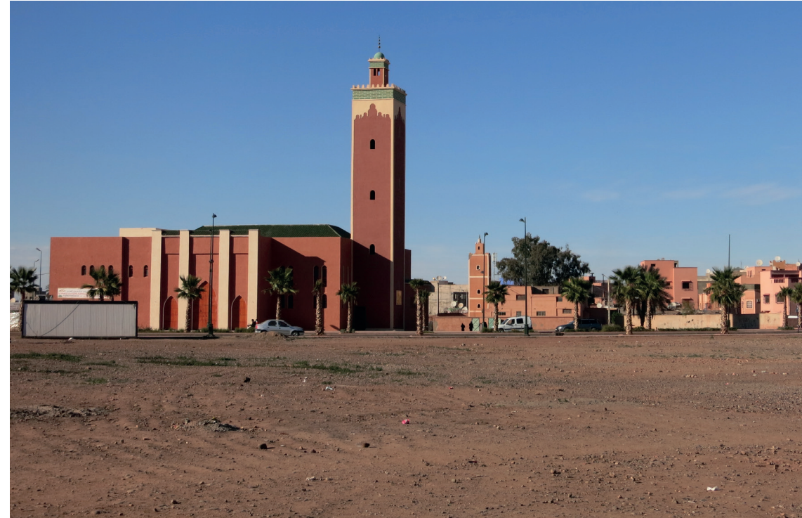
5 Front bâti de l'autre côté du boulevard Anakhil
