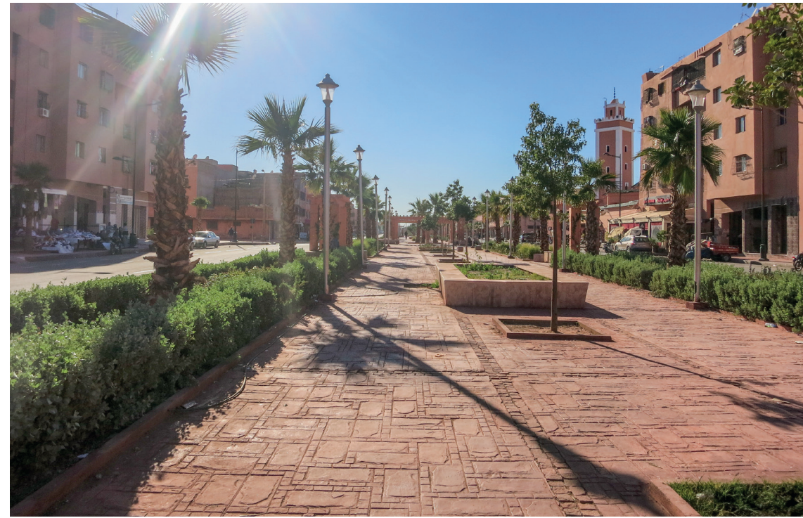
8 Aménagement du boulevard Anakhil
