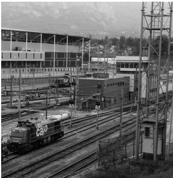
Fig.4 // Stade de la Praille en pleine zone industrielle
