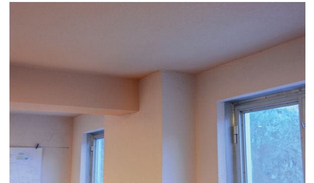
Emballage de la structure dans les chambres
