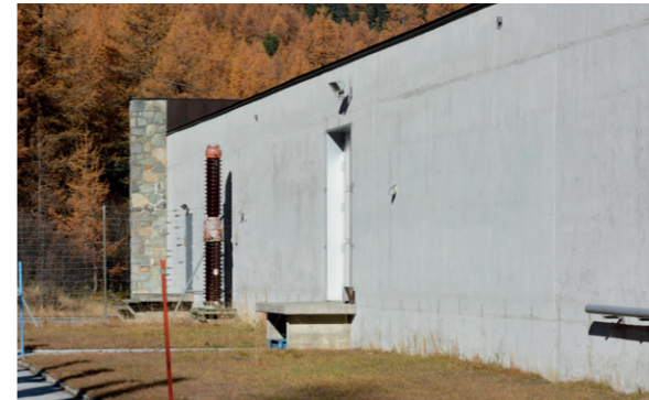
Nouvelle porte dans la façade ouest
