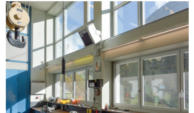
Nouvelles fenêtres, vue depuis le deuxième niveau
