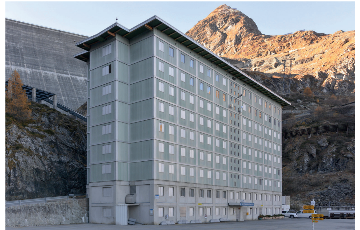
Façades nord et est
