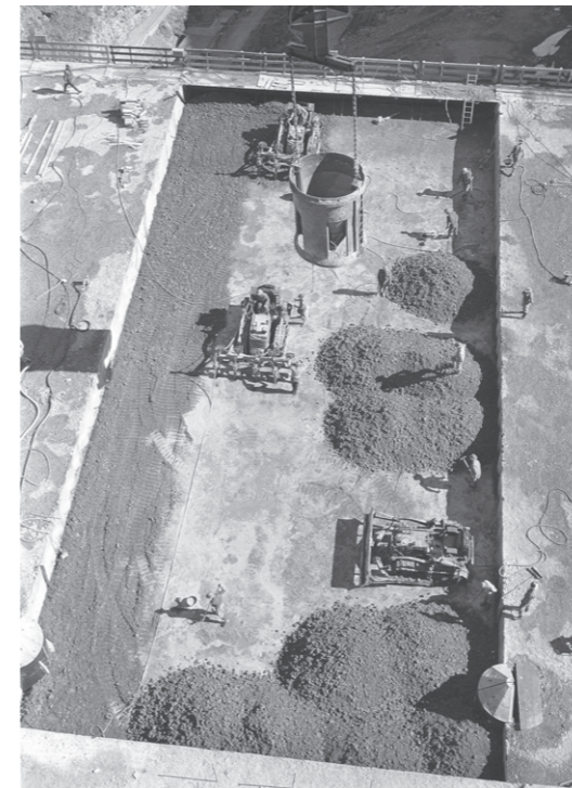
Bétonnage d'un bloc Image : Franck Gygli dans : Papilloud, 1999, p. 139
