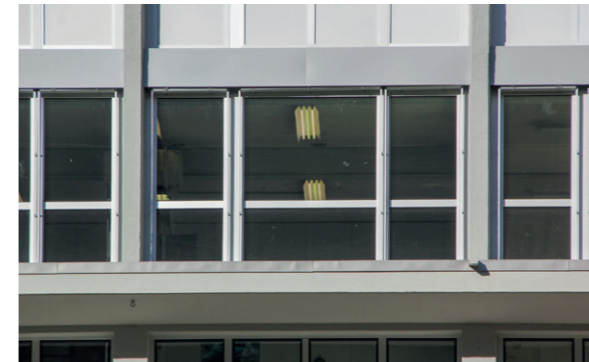
Nouvelles fenêtres, vue du deuxième niveau
