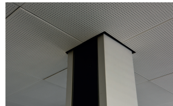
Porteur enrobé pour la protection anti-feu
