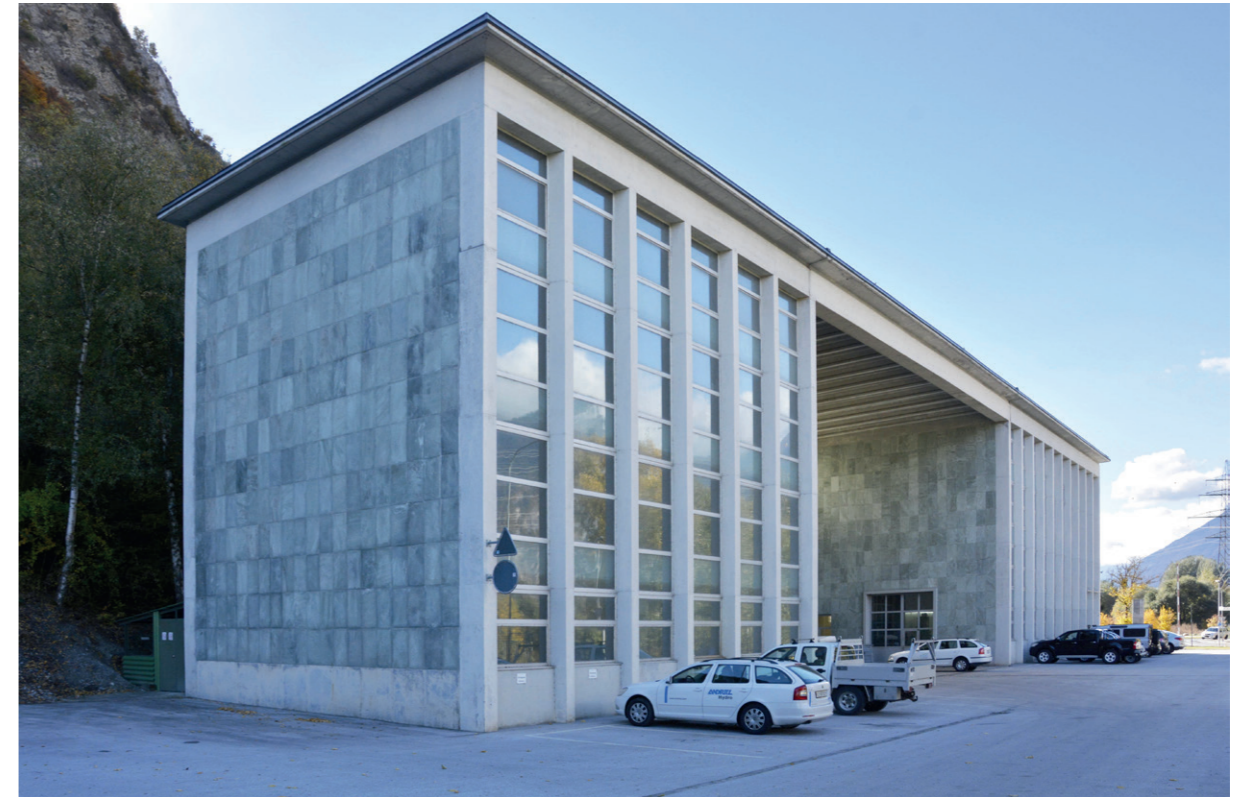
Façades nord et est
