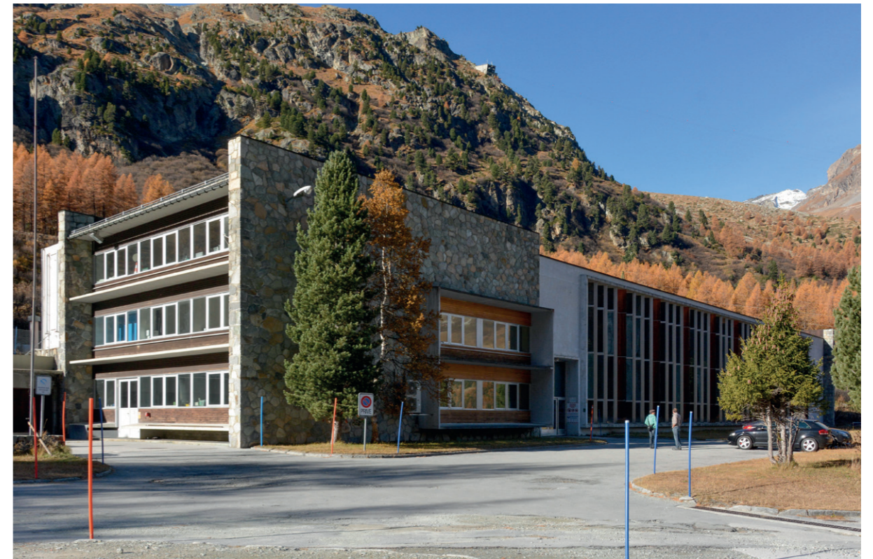
Façades nord et est
