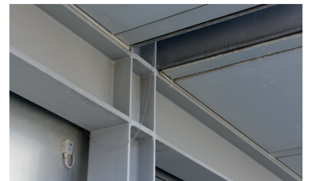
Structure extérieure du petit bâtiment
