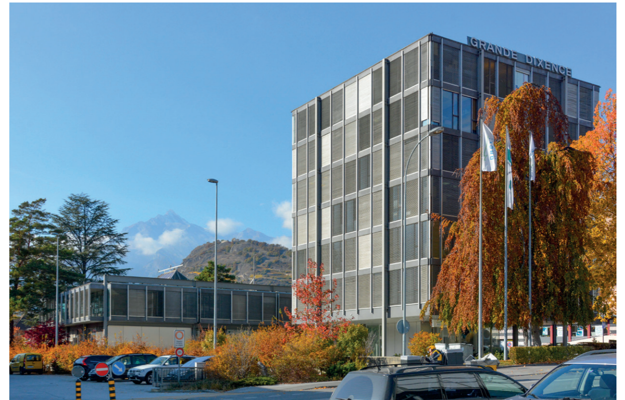
Façades nord et est
