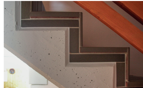
Détail de l'escalier
