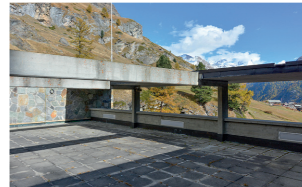
Terrasse sur la toiture
