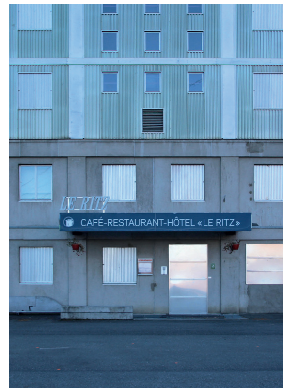
Façade nord et entrée principale actuelle
