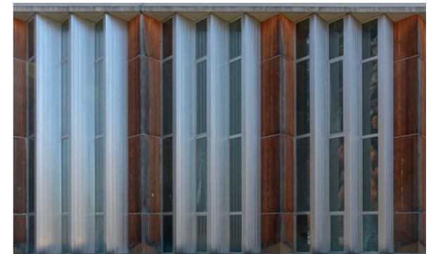
Façade de la salle des machines
