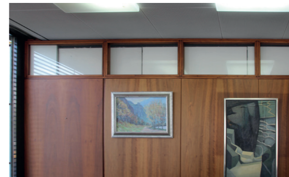
Cloisons et luminaires d'origine
