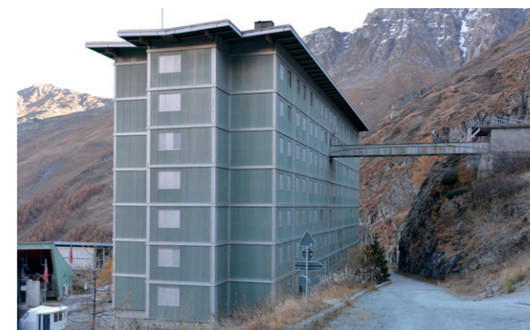
Passerelle d'accès directe au barrage
