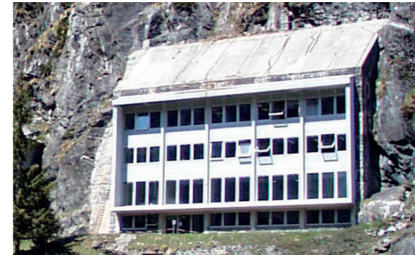
Façade avant le changement des fenêtres Image : Thierry Gabbud
