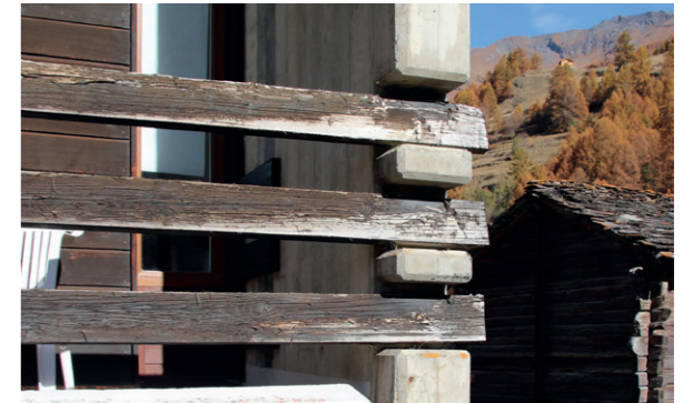
Détail du garde-corps
