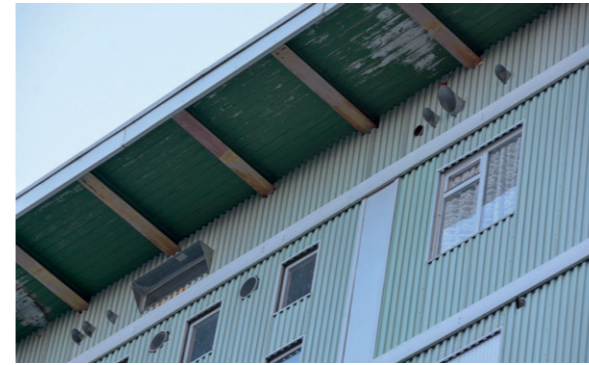
Façade percée pour les tuyaux de ventilation
