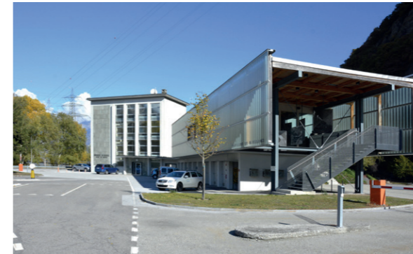
Pavillon d'exposition construit sur les garages
