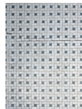
Carrelage des sanitaires et des vestiaires
