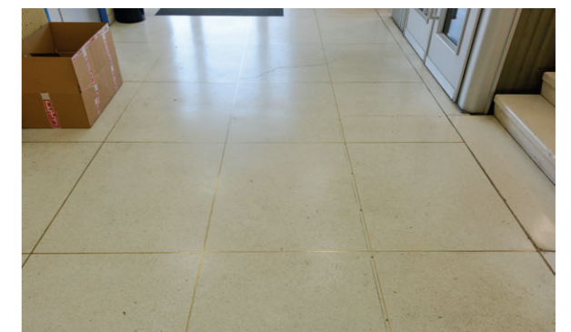
Dallage avec joint en laiton
