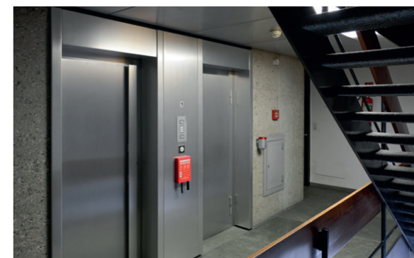
Noyau en béton brut
