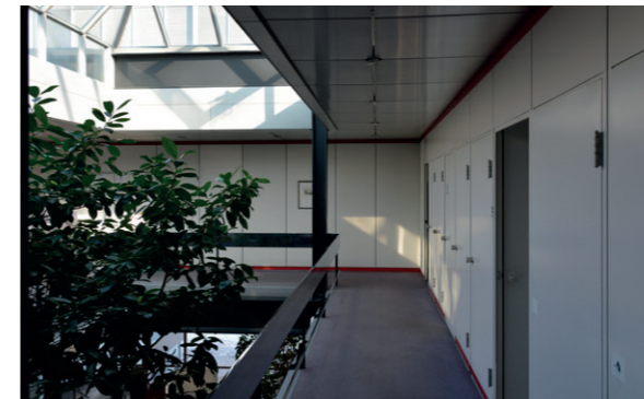
Patio transformé en verrière, vue depuis la coursive
