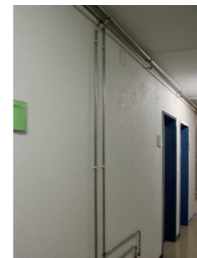
Nouveaux tuyaux pour l'eau sanitaire dans les couloirs
