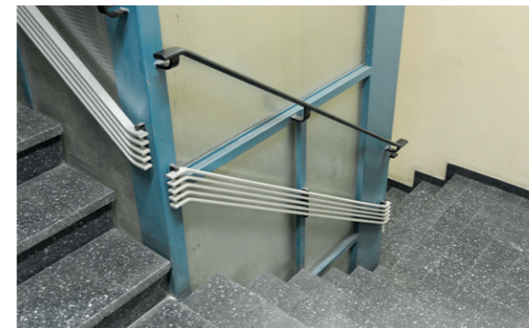
Bleu «Grande Dixence» d'origine dans la cage d'escalier (Arolla)
