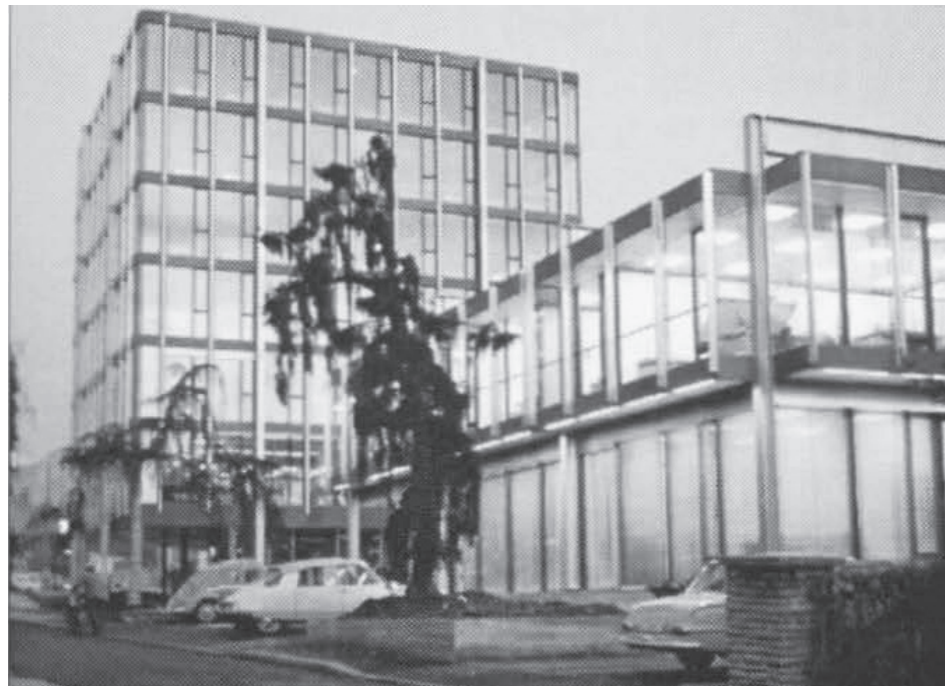
Façades nord et ouest Image : photographie inconnu dans : auteur inconnu (Das Werk n°8), 1973, p. 954
