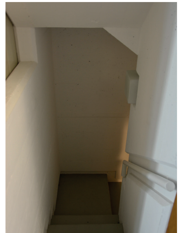
Main courante et lampe encastrées dans le mur en béton
