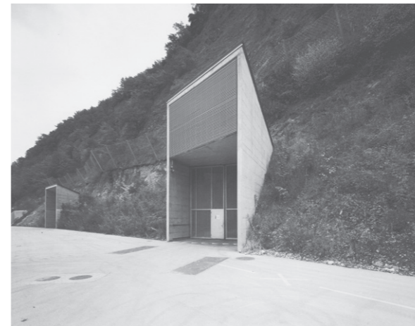
Entrée de l'usine de Bieudron Image : Botteri Balli, 2003, p. 148
