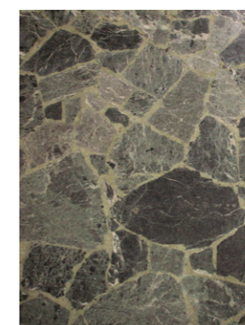
Sols en pierre dans les salles des machines
