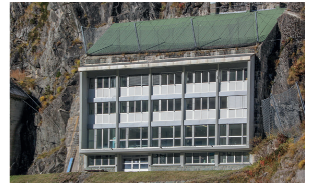
Façade après le changement des fenêtres
