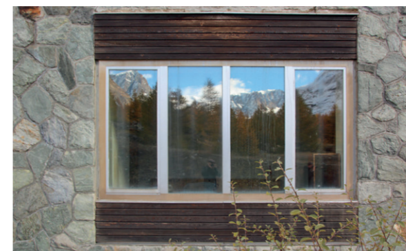
Menuiserie en mélèze et fenêtre en aluminium (Stafel)
