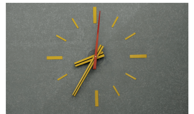
Horloges dans les salles des machines (Nendaz)
