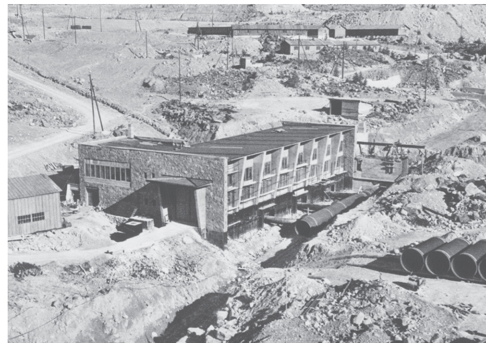
Construction des conduites d'eau autour de la station Image : photographie inconnue dans Gygli, 1961, p.57
