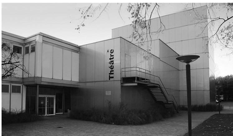
fig.7: Théâtre de Vidy, Lausanne - La couverture du bâtiment comme une enveloppe technique continue
