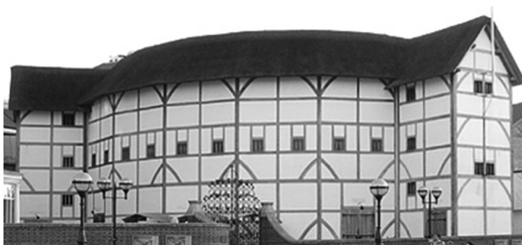
fig.6: The Globe Theatre, London - La façade comme une peau qui révèle le mode de construction
