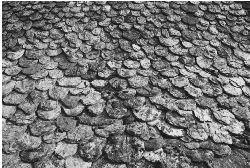
Toiture en lauzes de schiste
