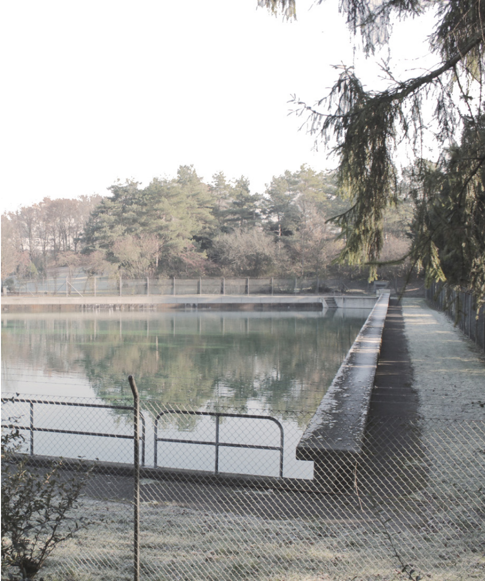
Bassin Altstetten - Zurich
