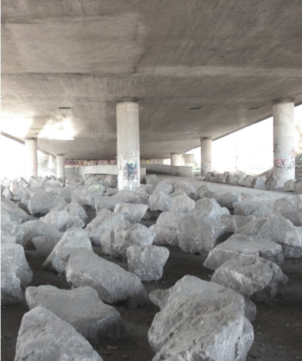
Pont autoroutier Wallisellen - Zurich
