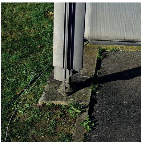
fig. 3.74 Raccord articulé, pièce d'appui et poteau, 2016
