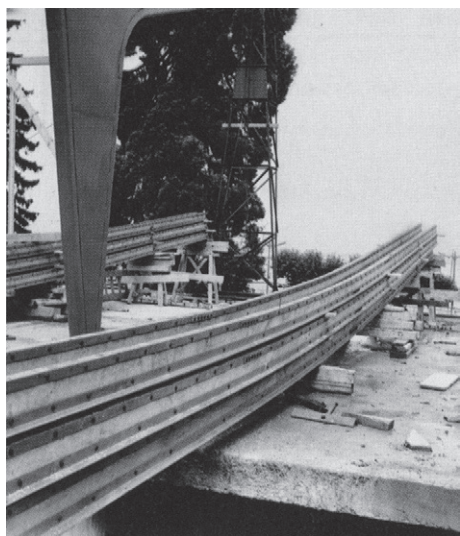
fig. 4.19 Photo de chantier, entreposage des poutres préformées de la toiture, 1957
