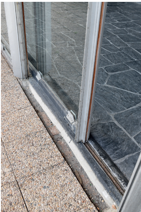
fig. 4.47 Vue extérieure, seuil porte coulissante, 2016
