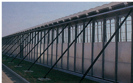
fig. 3.57 Vue façade sud avec contreventement de contreventement , 1999
