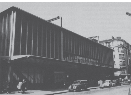
fig. 1.7 Maison du peuple et marché couvert, Clichy, 1937-1939 E. Beaudouin et M. Lods architectes, V. Bodiansky ingénieur-conseil, Ateliers Jean Prouvé constructeur, bâtiment restauré
