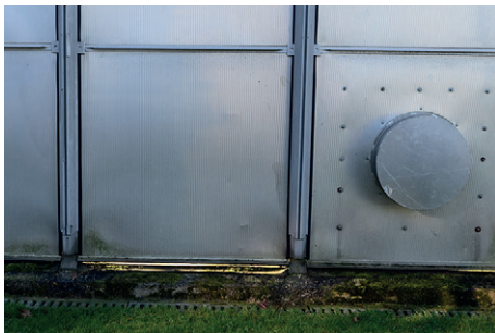
fig. 3.76 Bouche d'aération pour le système de chauffage sur la façade nord, élément non d'origine, 2016
