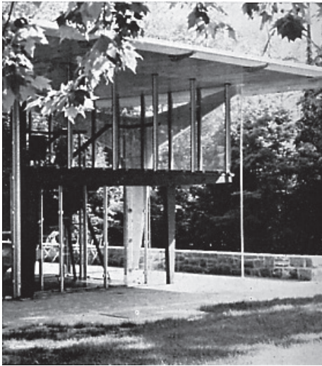
fig. 4.22 Vue de l'angle sud-est de la buvette avec la mezzanine et la béquille en arrière plan, 1958
