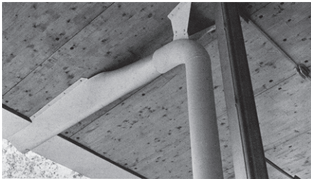
fig. 4.20 Détail descente d'eau pluviale , 1958
