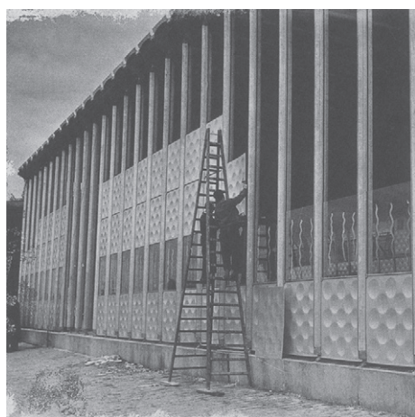
fig. 3.26 Pose des panneaux pleins et des vitrages, 1954
