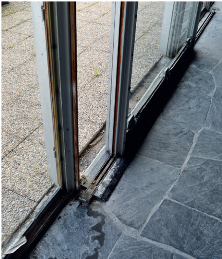
fig. 4.46 Vue intérieure, seuil porte coulissante, 2016
