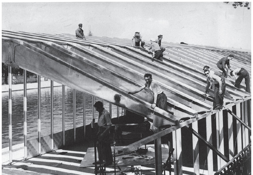
fig. 3.20 Montage de la structure sur le chantier, 1954
