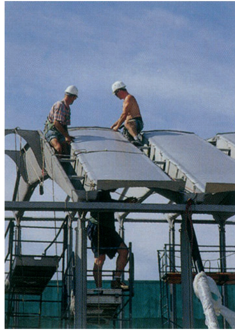
fig. 3.69 Mise en place et fixation de la couverture, 1999
