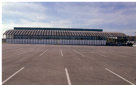
fig. 3.56 Vue façade sud du pavillon du centenaire de l'aluminium remonté et restauré à Villepinte, 1999
