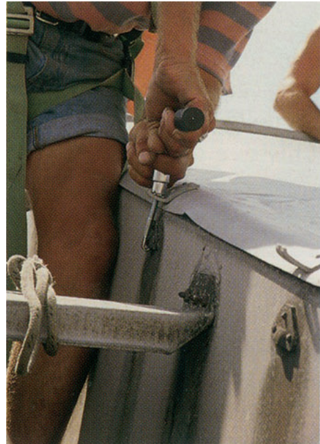
fig. 3.71 Fixation par boulonnage des éléments de la couverture, 1999
