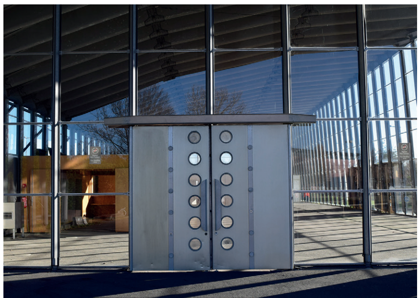
fig. 3.78 Détail de fermeture en pied de façade avec languette néoprène, élément non d'origine, 2016
