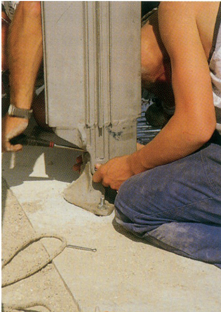
fig. 3.70 Mise en place et fixation articulée d'un «poteau-meneau», 1999
