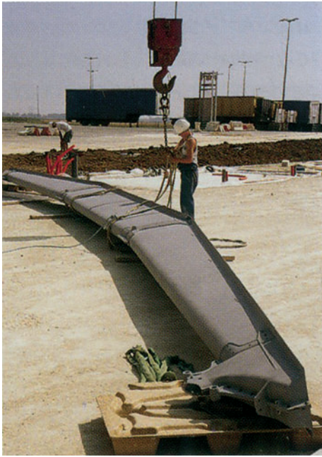
fig. 3.68 Mise en place des attaches pour le levage d'une «ferme-chéneau», 1999
