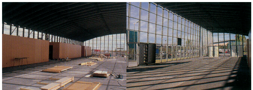
fig. 3.60 Vue intérieure avec les trois blocs de services, 1999 fig. 3.62 photo haut de page Vue façade ouest du pavillon, 1999
