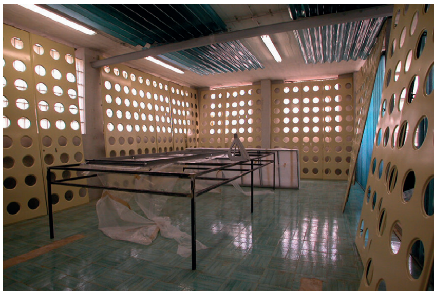
fig. 2.75 Local de peinture, restauration des panneaux de façade ajouré, ateliers Banneel, 2003
