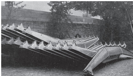
fig. 3.19 Entreposage des fermes sur les quais du Port du Gros Caillou, 1954
