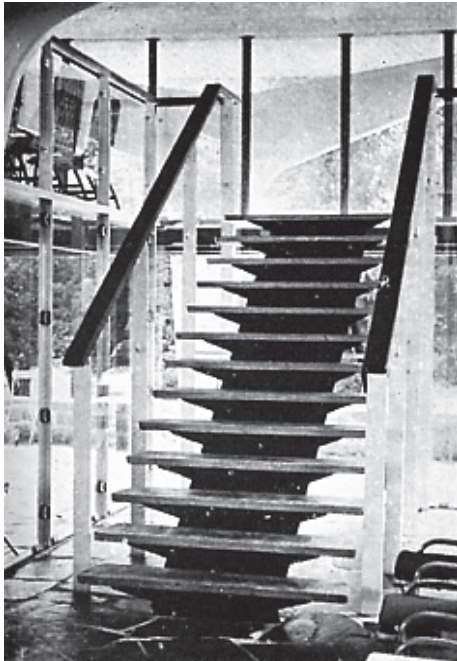
fig. 4.25 Vue intérieure de l'escalier de la mezzanine, 1958
