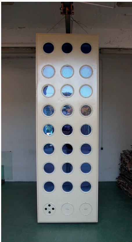
fig. 2.59 Restauration d'un panneau de façade ajouré de hublot bleuté, ateliers Banneel, 2003
