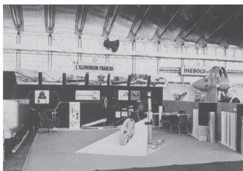
fig. 3.32 Vue intérieure avec le stand qui présente le processus de fabrication de l'aluminium, 1954
