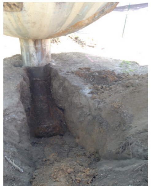
Creuse au pied de la mappemonde pour étudier les fondations
