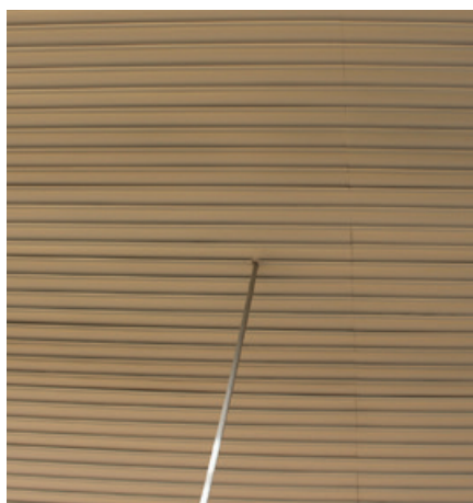
Faux plafond courbe
