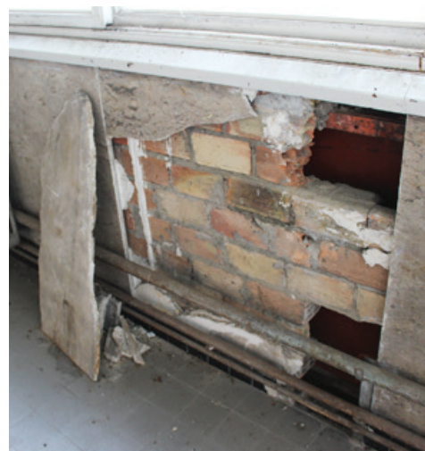
Plaque de travertin brisée
