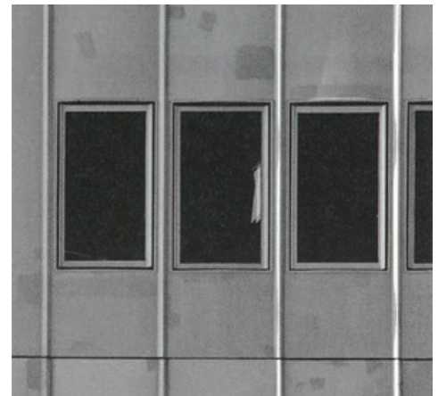
Revêtements métallique à Clichy
