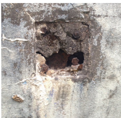
Ancien accrochage de la passerelle
