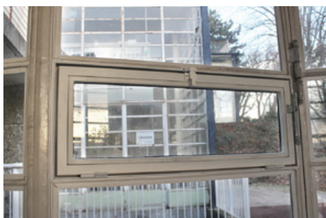
Petite fenêtre créée dans les pavillons
