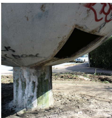
Trappe d'accès à l'intérieur du globe
