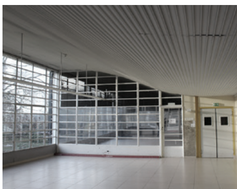
Faux plafond courbe réalisé
