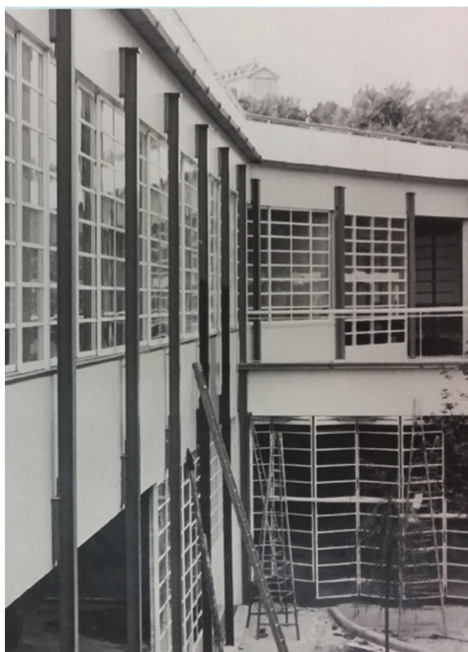
Menuiseries métalliques et allèges acier - façade sud
