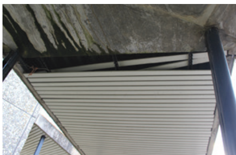
Sous-face d'une passerelle actuelle
