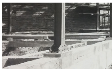
Photos de chantier de l'école
