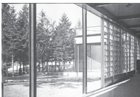
Baies coulissantes - préau Les châssis sont suspendus par des poulies, avec seulement un rail comme guide au sol.
