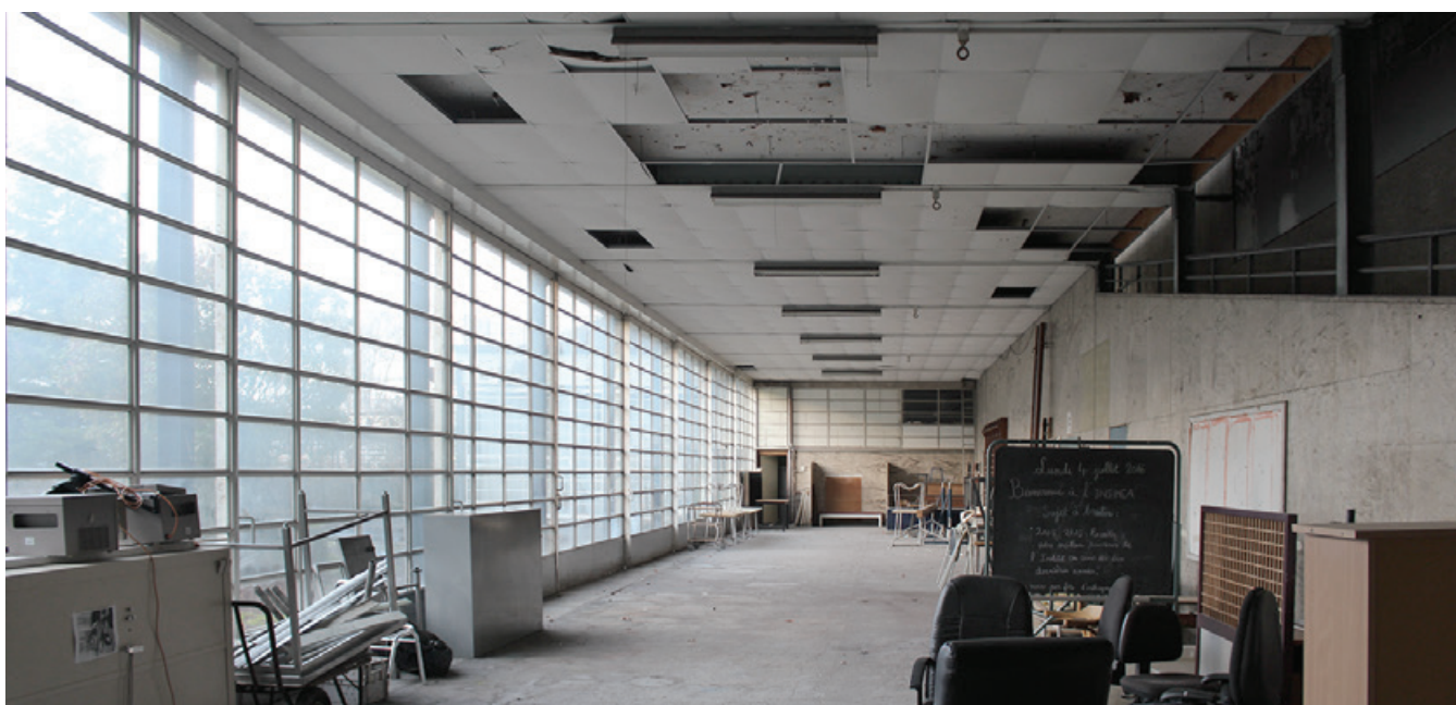
Ancien préau des filles, laissé à l'abandon
