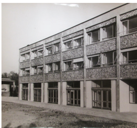
Bâtiment du CNEPA - Extrémité est
