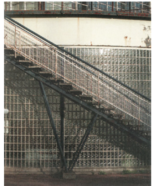
Escalier d'accès à la surélévation
