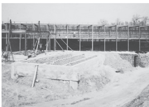
Photo de la construction du vide sanitaire sous une classe
