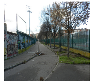
205. L'arrivée de la passerelle côté Paris (HS)
