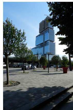
153. Vue du TGI en construction depuis CLICHY (HS)
