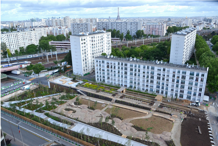
133. Photo de la couverture en travaux (Mairie de Paris)
