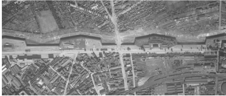
32. Vue de deux bastions Ortophoto Montreuil 1921 (IGN)
