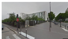
130. Photo du franchissement
