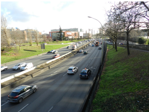
212. Talus sud ouest (HS)
