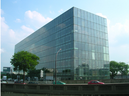
101. Dominique Perrault posa son volume de verre à cinq mètres des voitures. L'hotel industriel Bédier est dans le registre de l'autonomie à l'intérieur de l'échangeur d'Ivry
