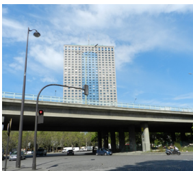
62. Le viaduc de la porte de la Villette (HS)
