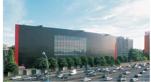
97. Architecture studio protège les étudiants par un double mur de béton, résidence universitaire Francis de Croisset paris 18e
