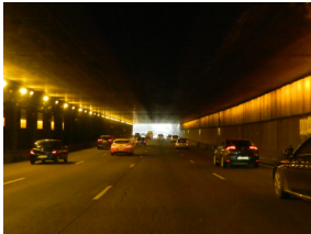
57. Vue d'un tunnel, sous face lisse et éclairage latéral (HS)
