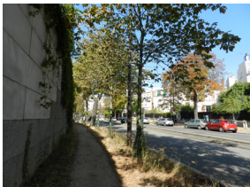
59. L'impact d'un mur anti bruit sur l'espace piéton (HS)
