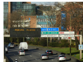
48. Portique d'indications avant la porte de Montreuil (HS)
