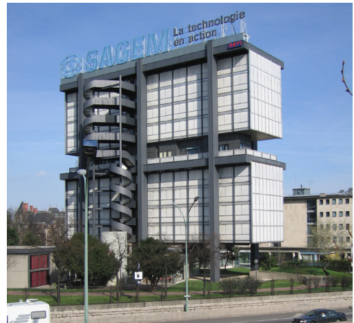
99. Claude Parent suspendit son bâtiment à de grandes poutres d'acier, maison de l'Iran, porte de Gentilly
