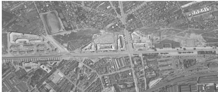
33. Les bastions démolis, les HBM commencent à prendre place Ortophoto Montreuil 1931 (IGN)
