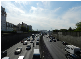
60. Le périphérique en tranchée maçonnée (HS)
