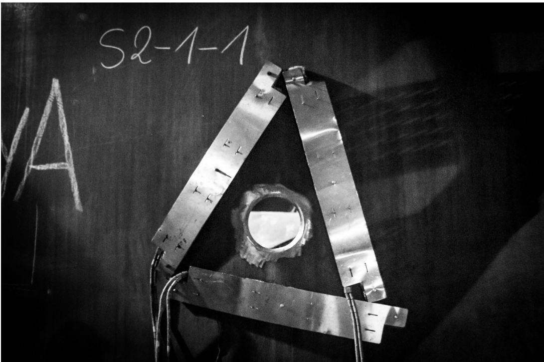
(d) Post-weld heat treatment of a grouting nipple.
