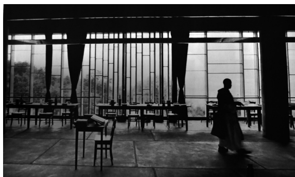
Le réfectoire. Application des pans de verre « ondulatoires » Œuvre complète 1957-65, p. 44
