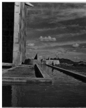
Réservoir à côté de la Haute Cour FLC L.3.11.351
