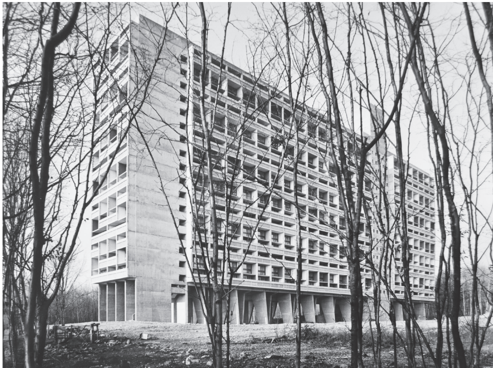
Figure 4: Vue de l'unité à la fin du chantier, en décembre 1960
