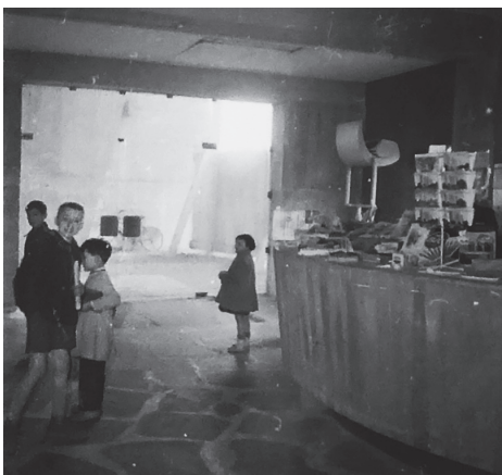
Figure 50: Entrée du hall avant la construction du sas, la lampe de Xenakis à droite de la porte
