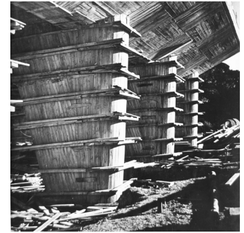
Figure 5: coffrage des pilotis - 1947
