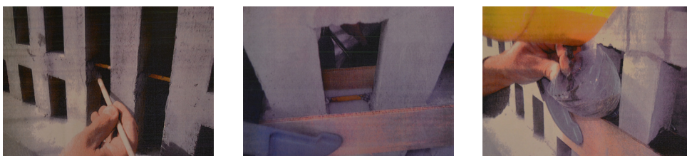
Figure 41 à 43: Réparation des claustras partiellement endommagés
