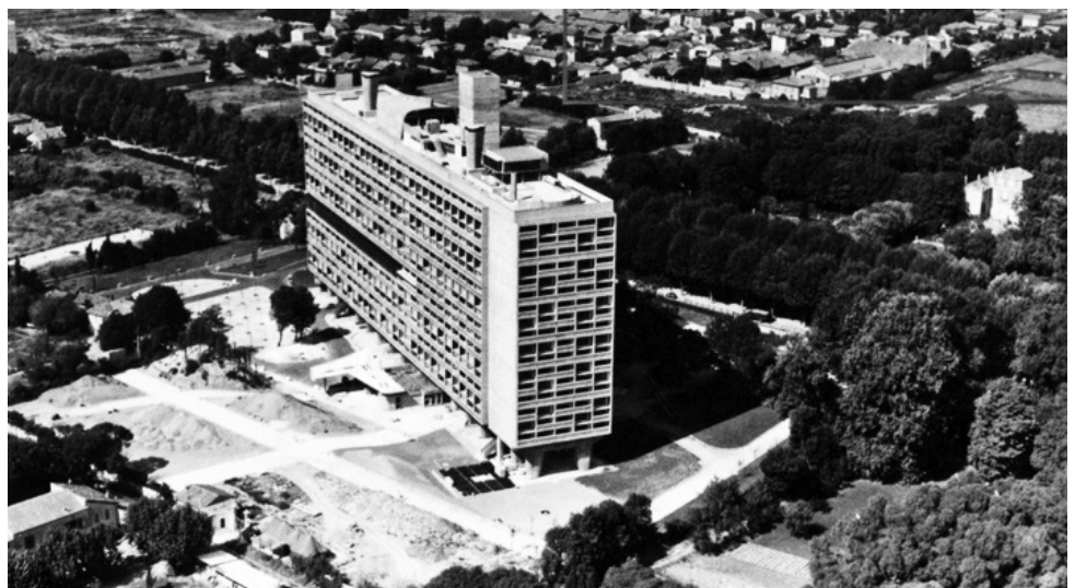
Figure 2: la cité radieuse à la fin du chantier, entourée de son parc.
