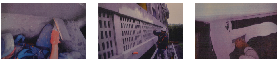
Figure 47: Enduit de micro-mortier
