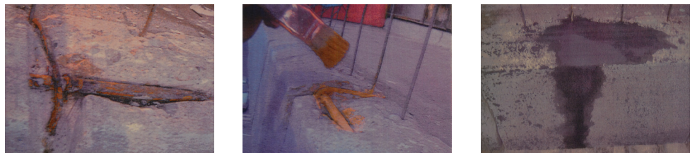
Figure 35 à 37: Traitement de la carbonatation des bétons
