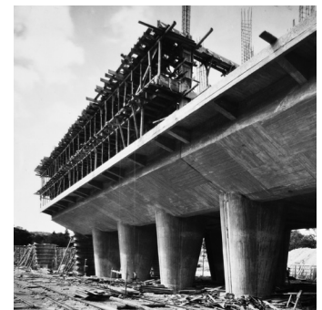
Figure 6: pilotis et étage technique
