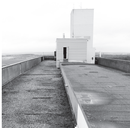
Figure 30: Toiture en fin de chantier avec l'armature en attente de recevoir la maternelle
