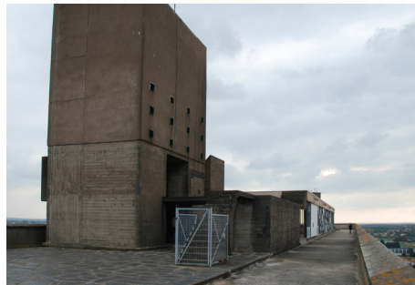
Figure 37 et 38: État des escaliers avant et après la construction des grilles
