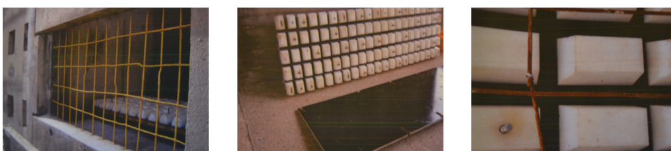
Figure 44 à 46: Réparation des claustras totalement endommagés
