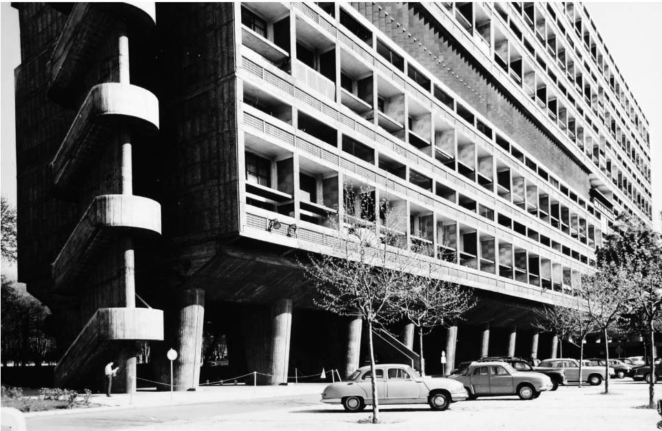
Figure 3: façade Ouest, on remarque la rue commerçante et ses brises soleils à mi-hauteur et l'esclalier de secour au nord
