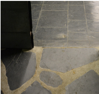
Figure 46: Opus incertum d'origine de la cage d'escalier et nouveau dallage du hall
