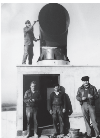
Figure 18: Ouvriers sur la toiture de l'unité le 4 octobre 1960
