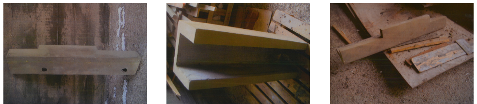
Figure 38 à 40: Préfabrication des éléments de façades
