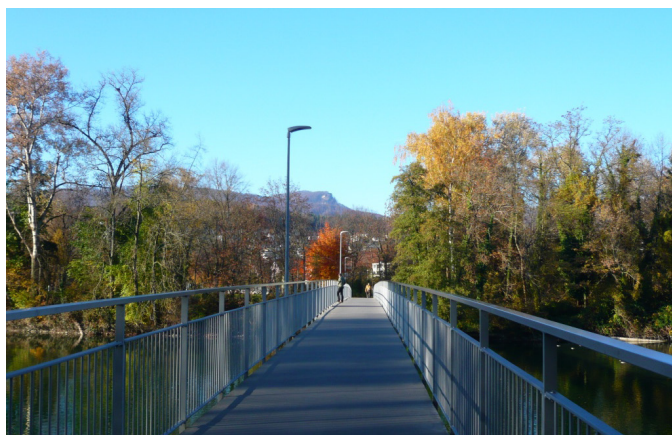
Passerelle entre la rive droite et la presqu'île est
