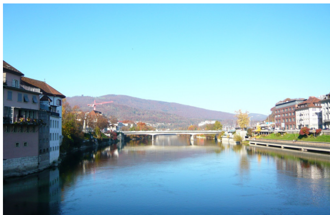
Vue vers le nord de l'Aar, aménagement récent de la rive droite pour les piétons
