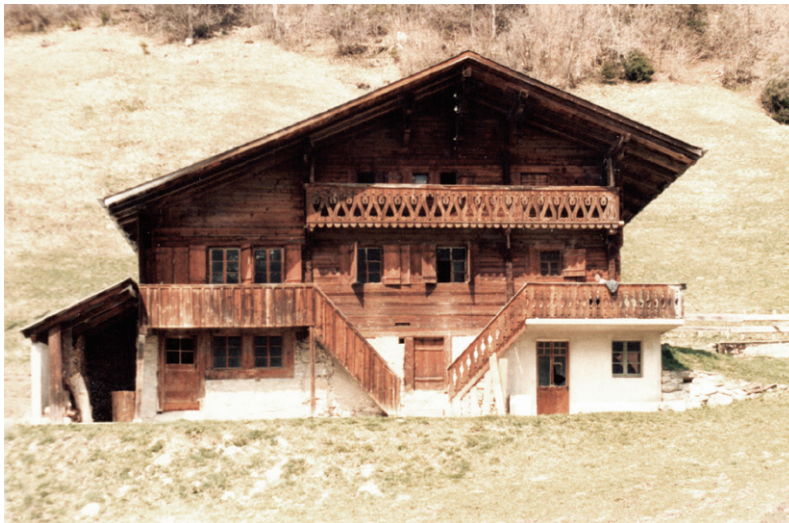
ill. 66. Bâtiment d'habitation avec grange-écurie à l'arrière au Rosex (vallée des Ormonts) (Famille Vallélian, 1985)
