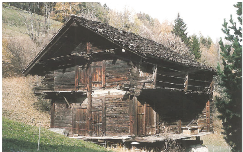
ill. 51. Grand raccard dont la façade est rigidifiée par un poteau, près d'Orsières (Val d'Entremont) (Anderegg et al. 2011)
