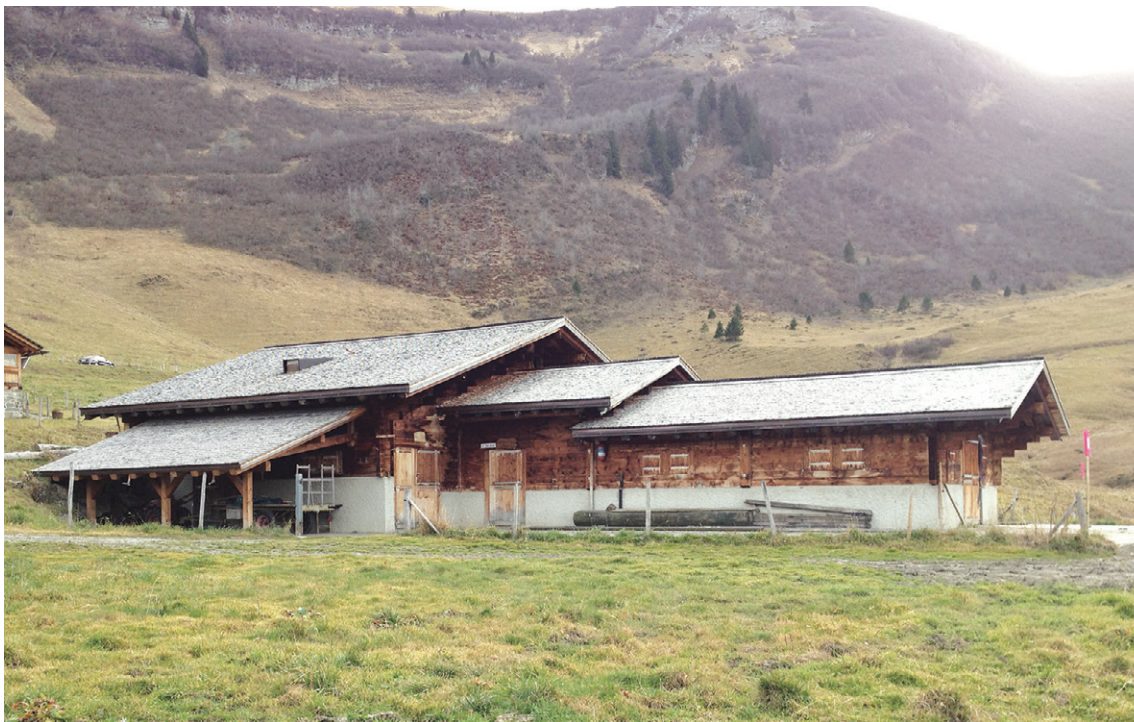
ill. 94. Écurie et locaux pour l'exploitation rurale à Taveyanne
