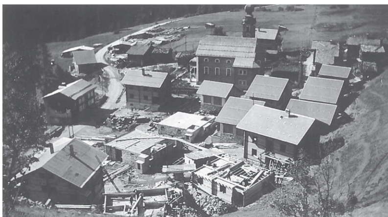
ill. 8. Blitzingen en reconstruction en 1933. C'est un exemple de retour à un mode traditionnel en bois dans la reconstruction après un incendie
