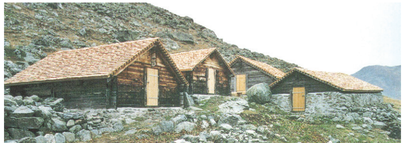
ill. 95. Le hameau de Engi après les rénovations (Antoniotti, 2003)
