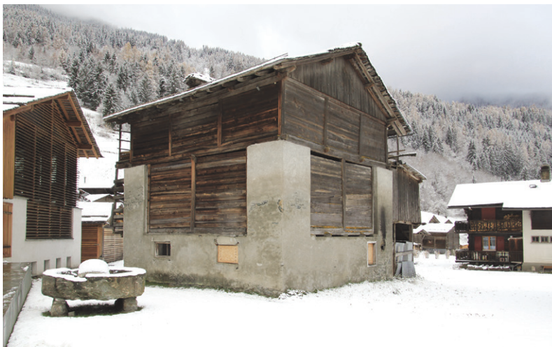
ill. 45. Grange chantonnée (Val de Bagnes), dans ce cas, les piliers d'angle ne montent pas jusqu'à la toiture qui a peut-être été surélevée. (Automne 2015)
