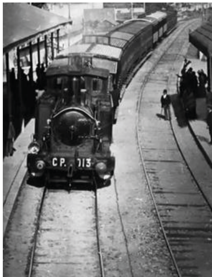
29 Première ligne du pays - 1863
