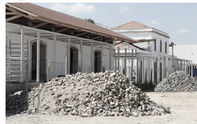
40 Réhabilitation de la Gare de Mora
