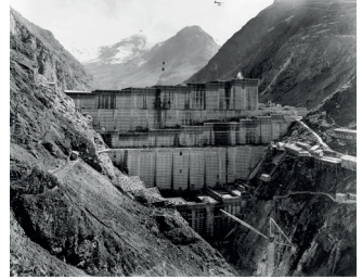
Chef d'œuvre de l'aventure hydraulique suisse du 20 e siècle, le barrage de la Grande-Dixence et ses 285 mètres de haut. 3000 hommes travailleront à l'édification de l'ouvrage. Impressionnant de par ses dimensions, c'est une construction à l'échelle du paysage qui l'entoure.
