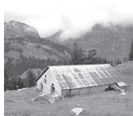
7 — La Porsogne (1888) Altitude — 1'604 m Typologie — chalet transversal Capacité — 46 têtes Production — terminée
