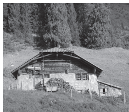
1 — Erpilles Dessus (1785) Altitude — 1'620 m Typologie — chalet transversal Capacité — 28 têtes Production — terminée
