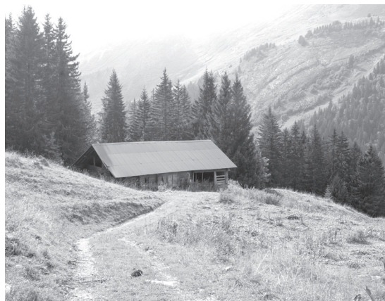
28 — Rodosex (1930) Altitude — 1'545 m Typologie — chalet longitudinal Capacité — 22 têtes Production — terminée
