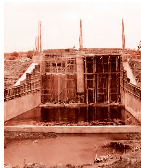
Fig 75: Travaux abandonnés de la construction d'une nouvelle écluse d'entrée pour manque de fonds.
