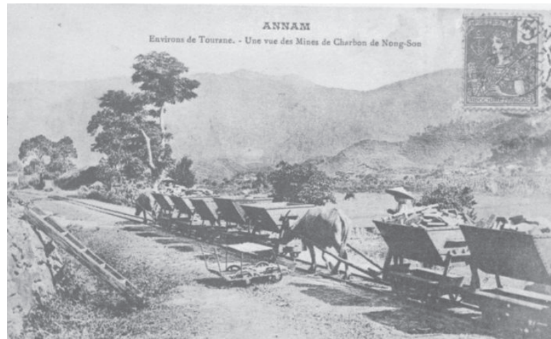
Une vue des mines de charbon de Nong Song aux environs de Tourane (Da Nang).
