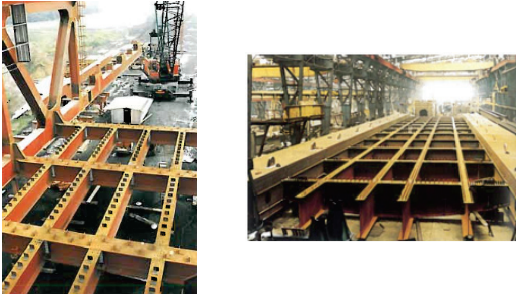
Figure 3 – Viaduc de la Deule (Bouley, 1993) and Viaduc de Donzère (© GREISH 1999)
