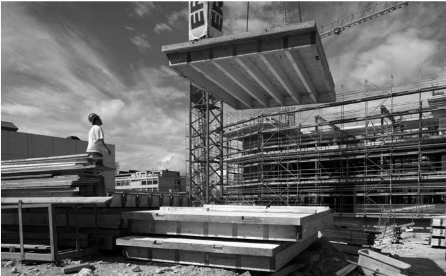
**Figure 4** : Montage sur le chantier des éléments de dalles préfabriqués en bois-béton. (photo : Yves André)
