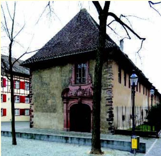
Bild 2. Das ehemalige Kloster „Kleines Klingental“ aus dem Jahre 1274 in Basel hat das Erdbeben von 1356 ohne größere Schäden überstanden.
