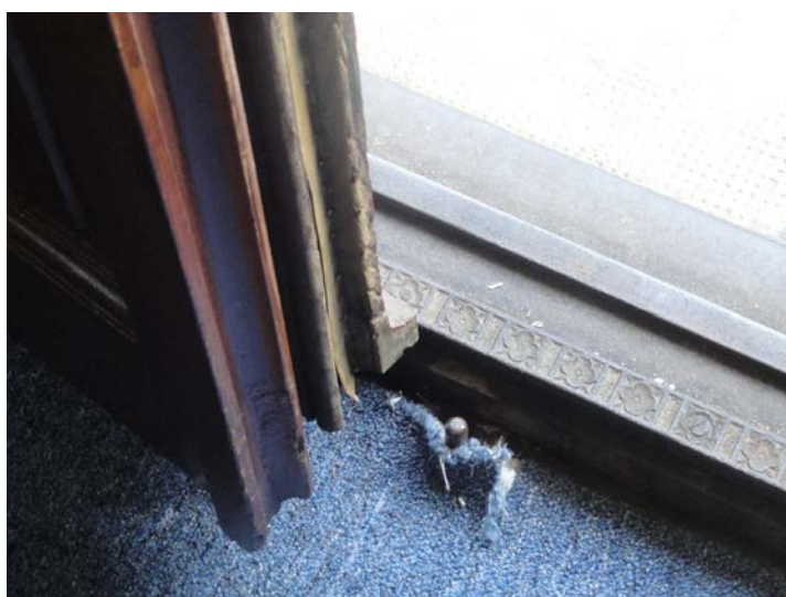
Détail de fenêtre couplée. Les deux fenêtres sont très proches et équipées de battants à gueule de loup.
