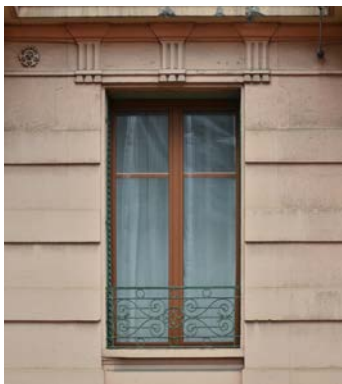
Fenêtres neuves en PVC G: Rue Beau Séjour 12, Lausanne D: Avenue d'Echallens 78, Lausanne
