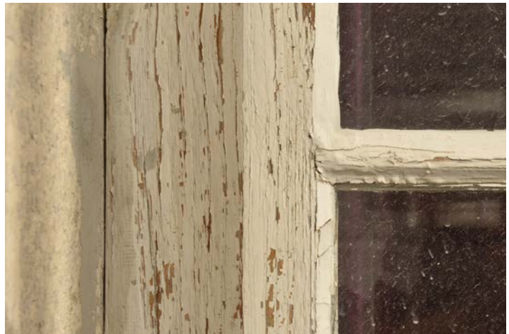
Etat de la peinture après plusieurs années d'exposition aux intempéries sans entretien. Avenue d'Echallens 83, Lausanne
