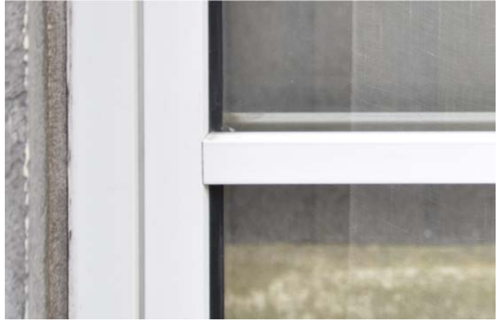
Détail latéral. Le petit bois est clipsé sur le cadre devant la vitre. Le joint de verre noir fait la transition entre le vitrage et le cadre blanc.
