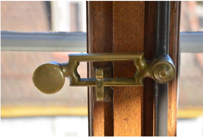
Poignée d'une espagnolette en laiton. Avenue d'Echallens 83, Lausanne
