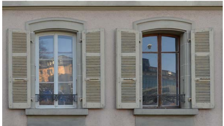
Fenêtres avec et sans contre-fenêtre. Chemin de Boston 5, Lausanne
