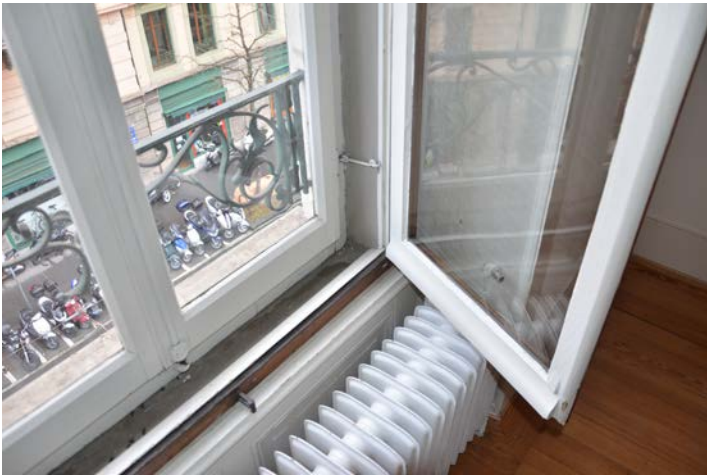
Fenêtres avec contre-fenêtre vue de l'intérieur. La contre-fenêtre démontable, posée dans l'embrasure est fixée au cadre de la fenêtre permanente au moyen de crochets. Avenue d'Echallens 83, Lausanne
