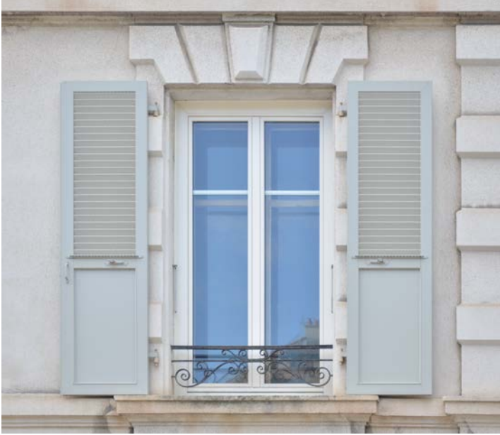
Fenêtre avec contre-fenêtre en PVC. Avenue du Léman 14, Lausanne
