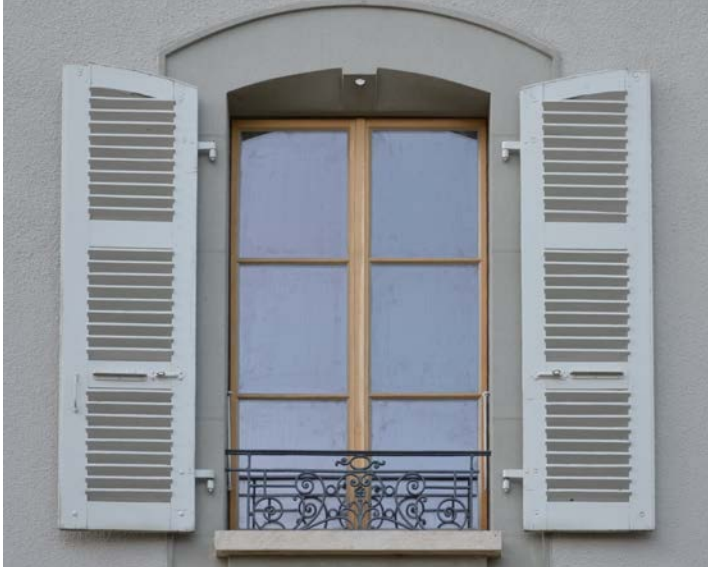
Fenêtre ancienne rénouvée vue de l'extérieur. Rue de la Gabelle 20, Genève
