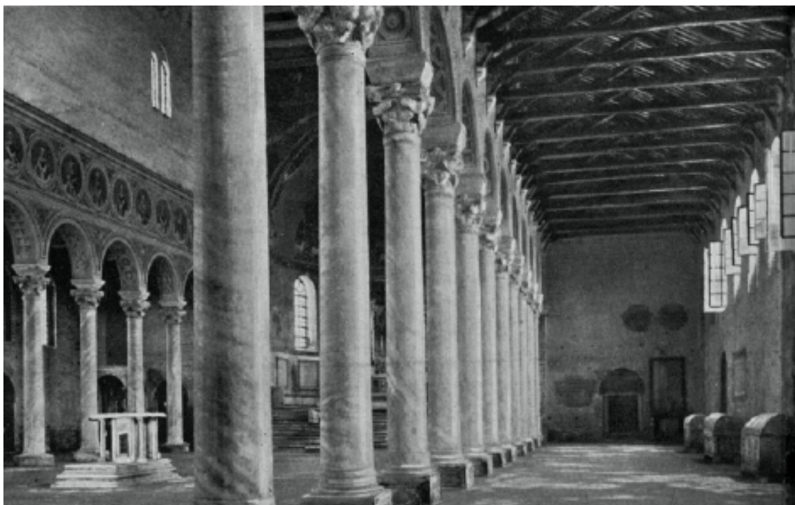
Fig. 18 - fotografia della navata laterle della basilica, 1918
