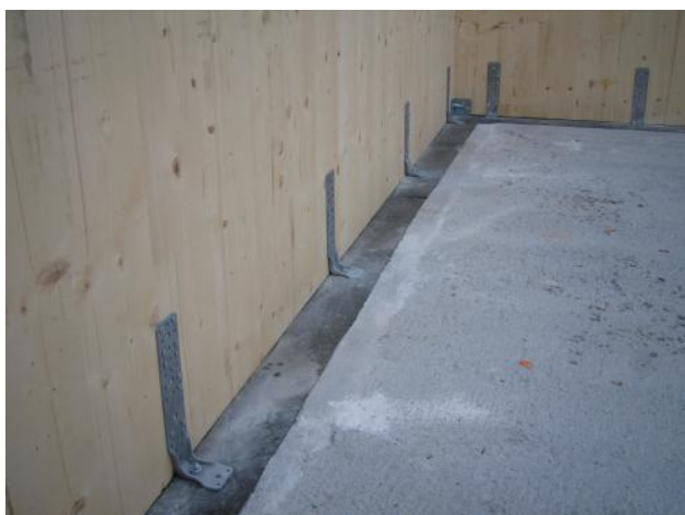
Fig. 82 - fasi di montaggio in cantiere dei pannelli di X-Lam
