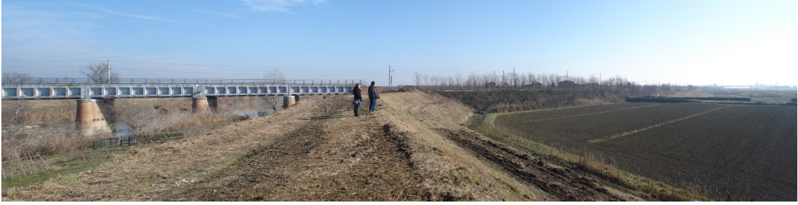
Fig. 55 - l'argine e la linea ferroviaria
