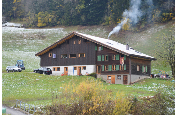
Figure 4: Bâtiment mixte réaffecté
