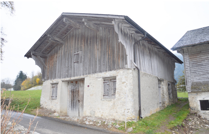
Figure 43: Photo actuelle accès Nord
