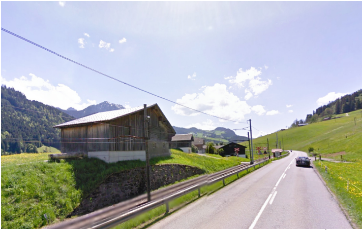
Figure 54: Photo actuelle: accès Nord
