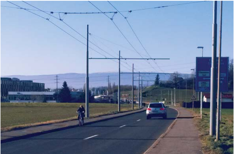
FIG. 40 : ABSENCE DE PISTE CYCLABLE SUR LA ROUTE DE CHAVANNES
