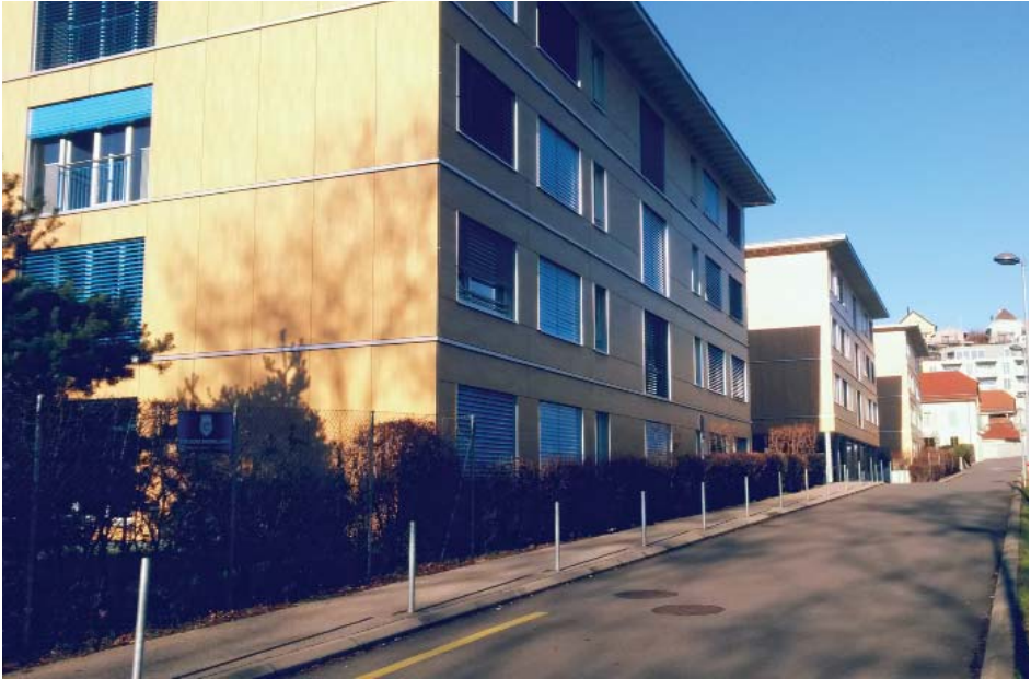
FIG. 46 : RUE QUI AMÈNE AUX LOGEMENTS ÉTUDIANTS, GRILLAGÉE AVEC LE PANNEAU DE SURVEILLANCE VIDÉO
