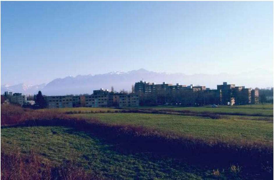
FIG. 21 : VUE SUR LES DEUX ENSEMBLES BÂTIS : LES LOGEMENTS ÉTUDIANTS ET LE QUARTIER DE LA BOURDONNETTE
