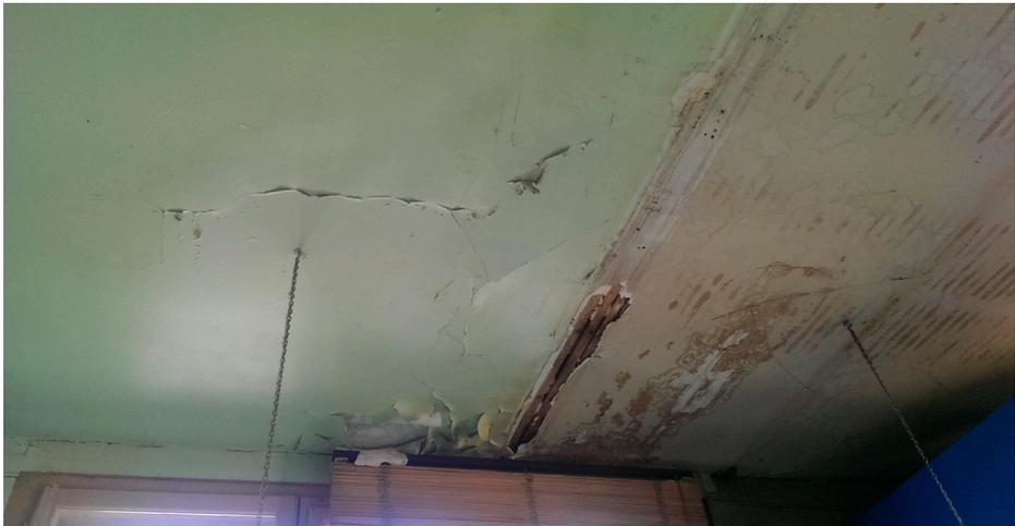
*Plafond en très mauvais état. Le 1er étage possèdent les fenêtres d'origines posant des problèmes d'échanges thermiques importants avec l'extérieur. Le sommier métallique soutenant le plancher.*
