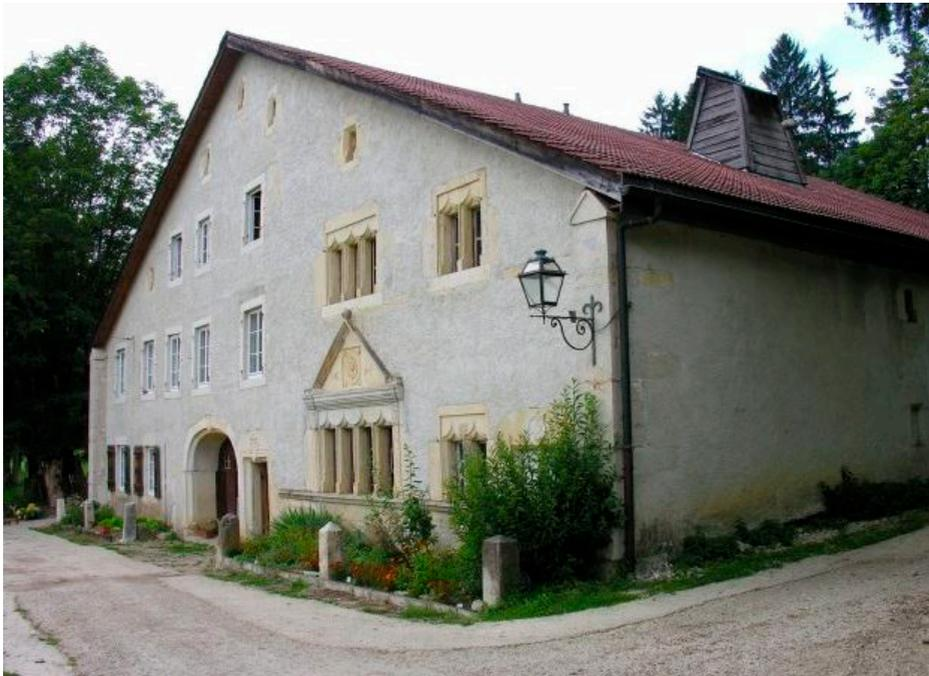
*Façade sud, les petites ouvertures typiques des fermes côtoient les bandeaux de fenêtres de l'ancien atelier d'horlogerie. On voit aussi la cheminée trapézoïdale donnant dans le fumoir, toujours utilisé.*
