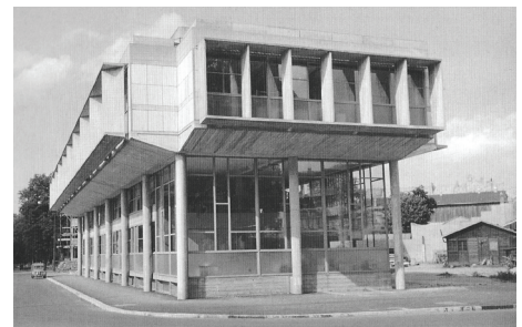
10 Immeuble EDF, 1951-52, Mulhouse
