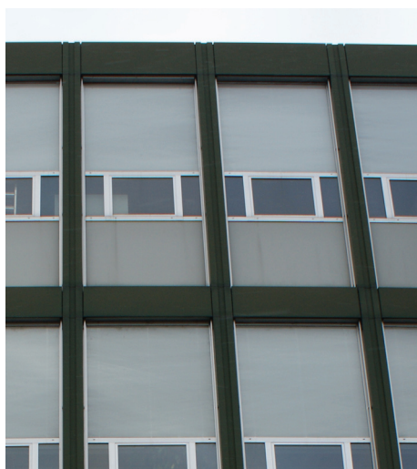
133 Façade transversale du bâtiment IRL1 telle que rénovée. Les caissons de store déprécient la dominante verticale de la façade initiale
