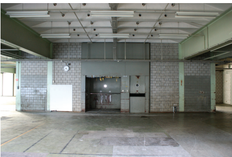
74 Les blocs centraux contiennent la circulation verticale et les locaux techniques
