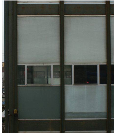
180 Détail de la façade de Mayer&Soutter: en bas à gauche, un vitrage a été remplacé, en bas à droite, la fibre de verre la capillarité fait monter l'eau entre les deux verres du panneau Thermolux et altère la fibre de verre.
