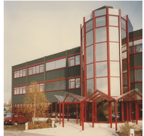
122 IRL2, vue sud avec la cage d'escalier vitrée
