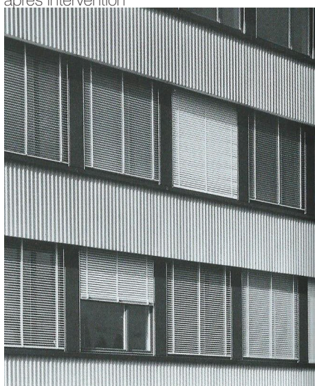
174 Détail de la façade du bâtiment Eternit avec les plaques Eternit à ondulations courtes
