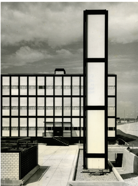
65 Vue du bâtiment Mayer&Soutter depuis l'esplanade Est, au premier plan, la cheminée du chauffage central
