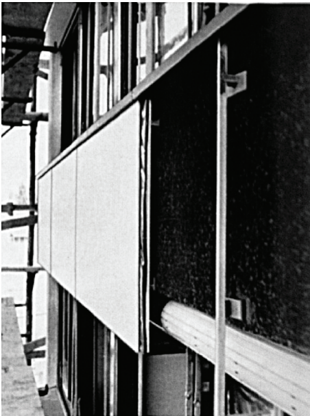
98 Utilisation de plaques Pélichrome sur structure métallique à l'immeuble comercial Kilintra, Peter Hirzel
