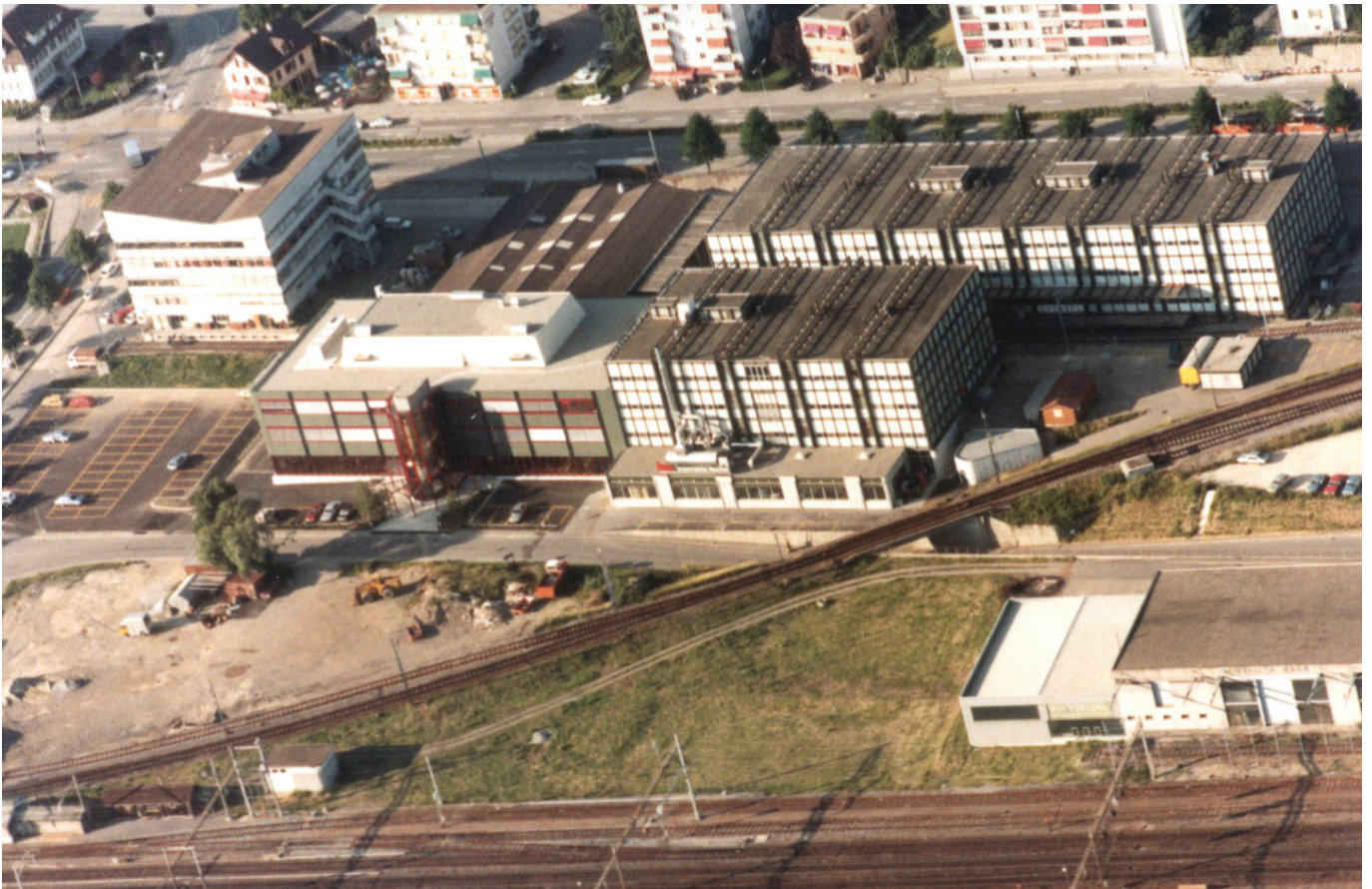
112 Vue aérienne du site du Closel à l'inauguration du bâtiment IRL2 en 1984
