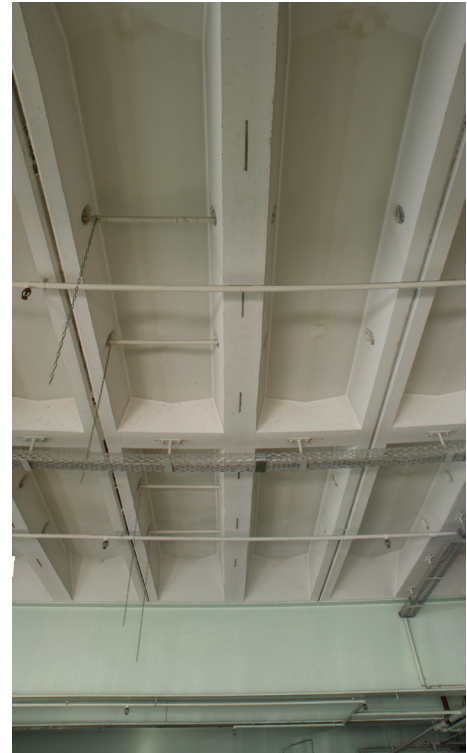
52 Les hourdis préfabriqués reposent sur les poutre métalliques principales. Leurs trous permettent d'accrocher les installations techniques et de faire passer les câbles
