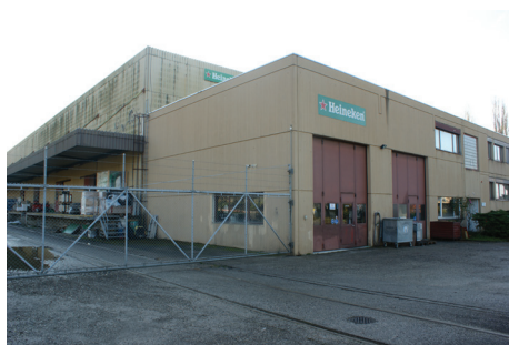
158 Dépôt Heineken, futur dépôt de tram
