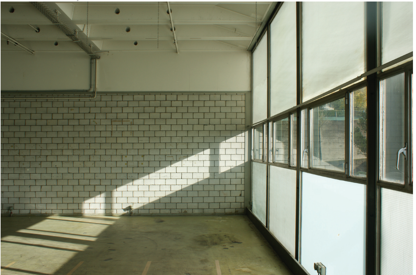
59 Vue intérieure de la façade
