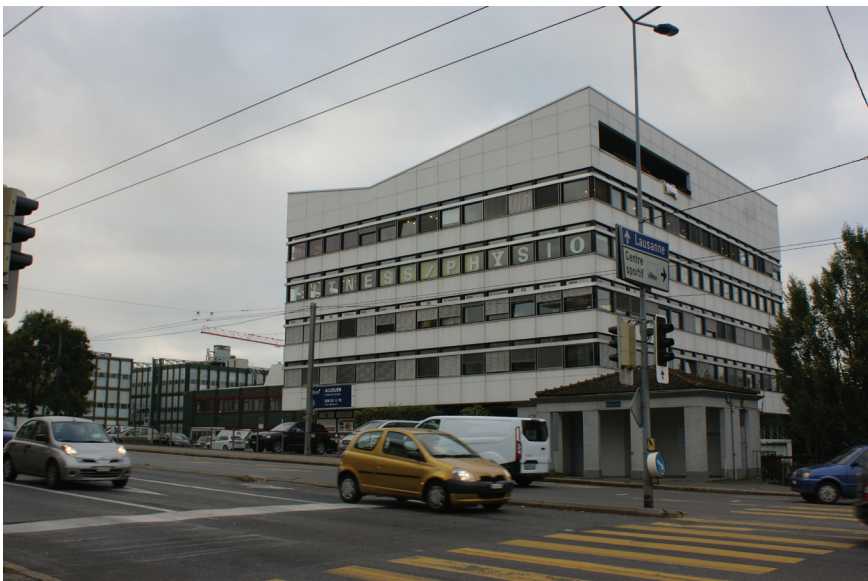
175 Vue sur le bâtiment Eternit depuis le carrefour de la Croisée
