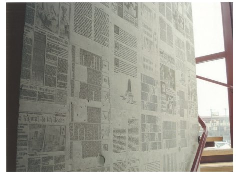
123 Vue intérieure de la cage d'escalier. Le mur en béton de la cage d'ascenseur utilise le brevet Bétoprint
