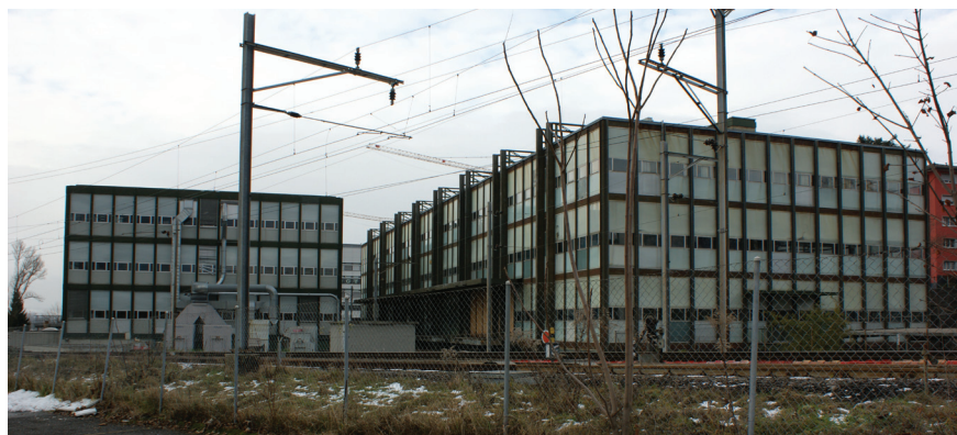
134 À gauche: IRL1 avec façades rénovées, à droite: Mayer&Soutter dans l'état initial
