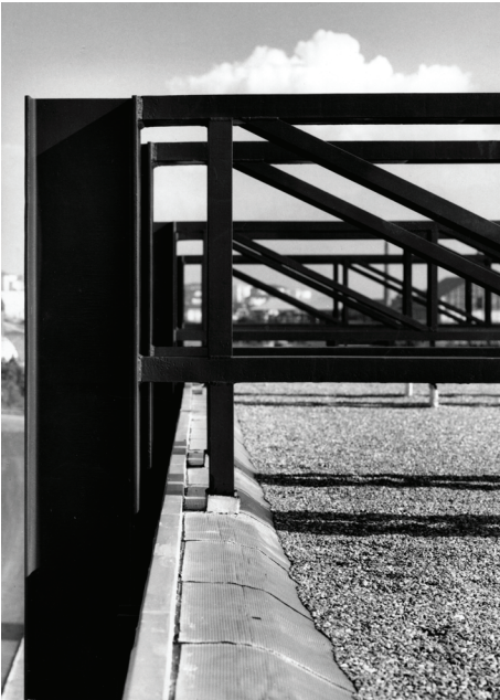
46 Vue des treillis de toiture
