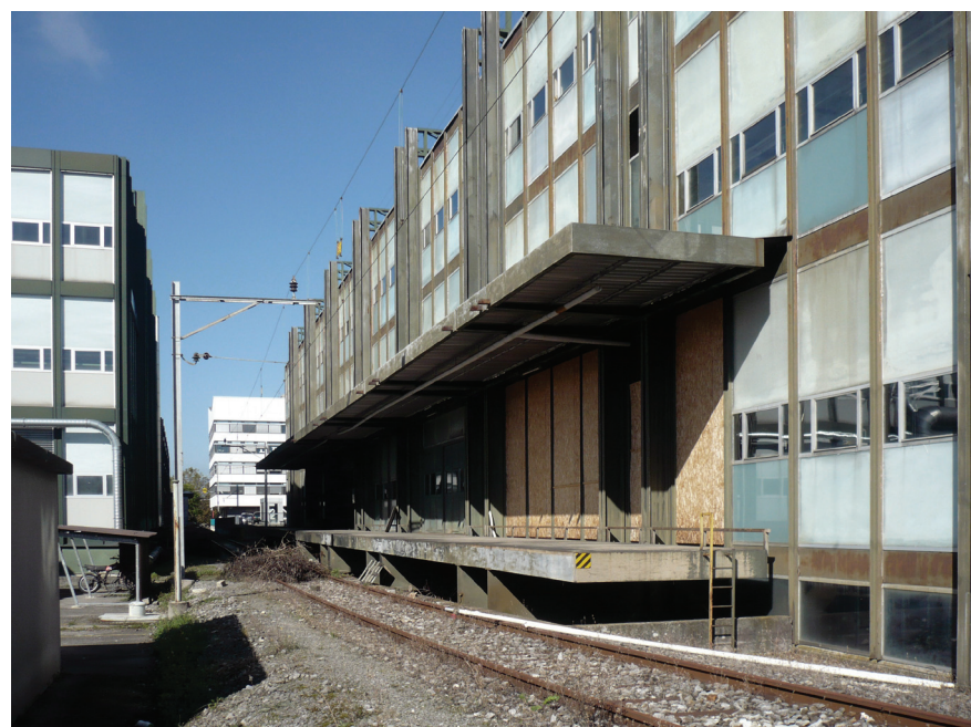
179 État global du bâtiment Mayer&Soutter
