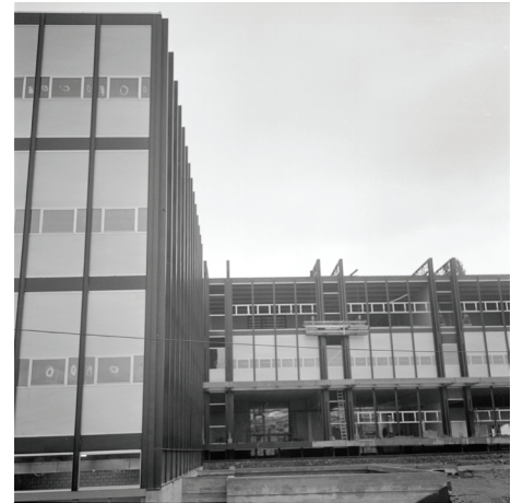
57 Construction des façades
