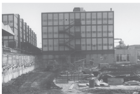
120 Vue de la façade Ouest de IRL1 à la construction de IRL2, 1984
