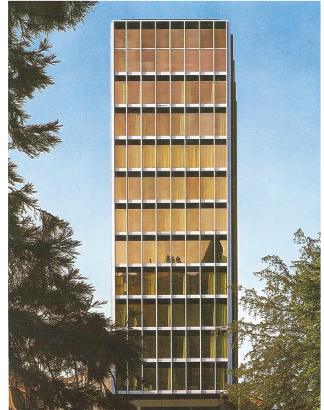
26 La tour de l'avenue de la Gare est composée d'un noyau de contreventement et de service en béton et de façades porteuses en acier. Sur les façades latérales, quatre profilés en H en acier soutiennent les dalles de chaque étage. La façade frontale est quant à elle non-porteuse et en porte-à-faux. Les tôles recouvrant les têtes de dalle et les poteaux sont peintes en noir, ce qui a pour effet de souligner la légèreté des façades qui sont de teintes claires (cadre en aluminium brossé et verres orangés). Le rez, très transparent et ayant seulement la moitié de la surface des autres étages, est accessible depuis l'avenue de la Gare à travers un parvis. Il contient l'accueil pour les visiteurs.
