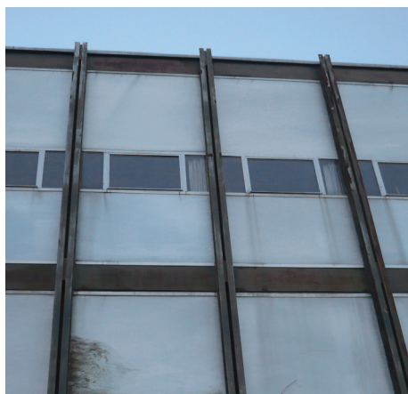
132 Façade transversale du bâtiment Mayer&Soutter, en l'état initial
