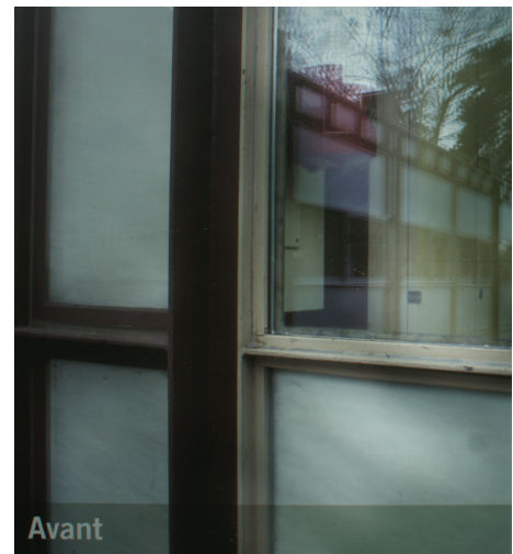
164 Etat initial de la façade
