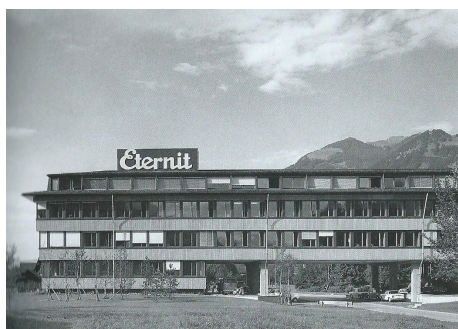
173 Immeuble administratif Eternit à Niederurnen: il est difficile de distinguer l'état avant et après intervention
