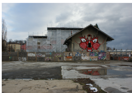
153 Avancement du chantier fin 2014, au premier plan, l'annexe
