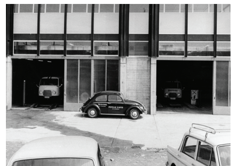
49 Les fondations en béton reprennent la saillie des cadres, ce qui affirme une direction dominante verticale.
