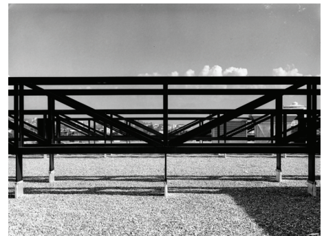
48 Vue des treillis de toiture, les connexions se font à travers l'étanchéité.
