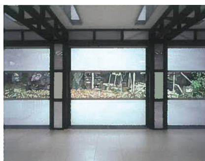
168 Vue intérieure après rénovation: le faux-plafond cache l'épaisseur de la structure
