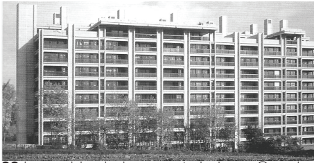
23 Immeuble de logement de luxe, Grand-Saconnex
