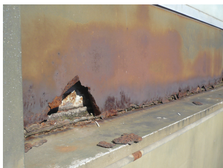
178 Tôle de tête de dalle sur la façade est
