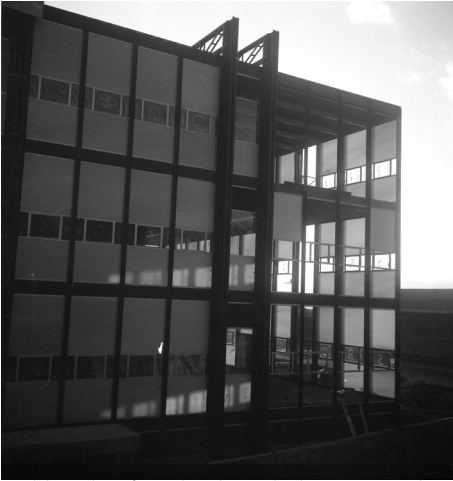
55 Vue des façades lors de la construction. La face intérieure se confond avec la face extérieure
