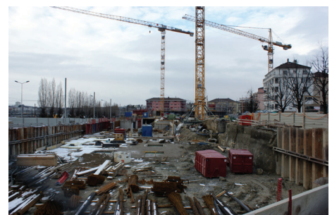
151 Avancement du chantier fin 2014
