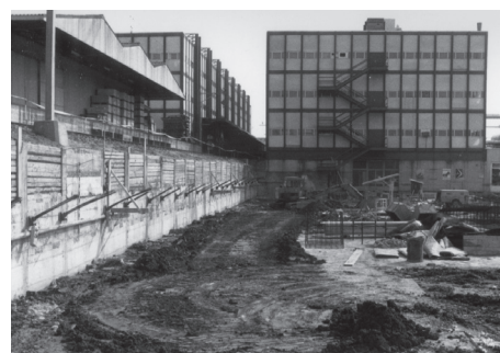
41 Vue des Imprimeries Réunies depuis l'Ouest. A gauche, le dépôt Eternit cache le bâtiment Mayer&Soutter
