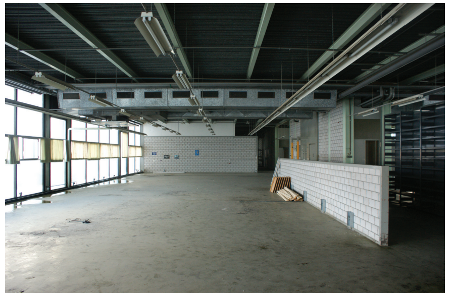
75 Au troisième étage, la structure disparaît et les cloisons de différentes hauteurs articulent l'espace
