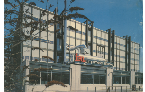
117 Extension pour une rotative au rez des Imprimeries Réunies, 1979
