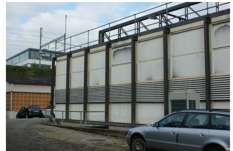
71 Jean-Marc Lamunière, Usine Favarger, 1962-68, la structure secondaire rejoint le sol à l'extrémité du bâtiment
