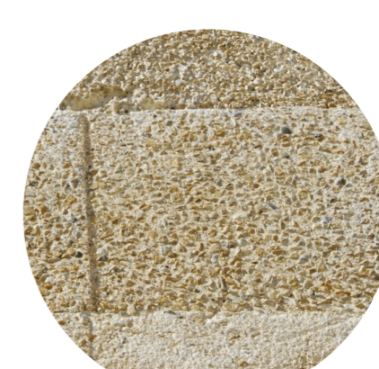
Béton coulé en strates avec granulats du site
