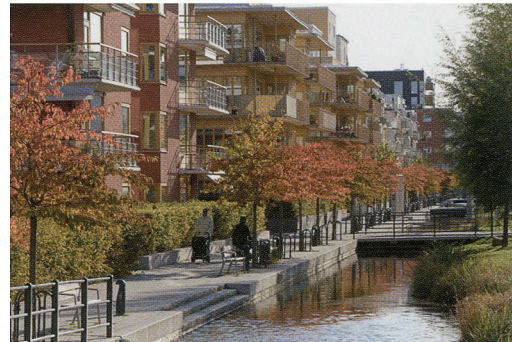
Figure 51. canal de rétention
