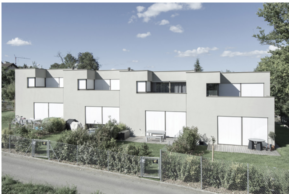
Maisons contiguës à Lully, densité 0.44, Hervé de Giovannini Architecte
