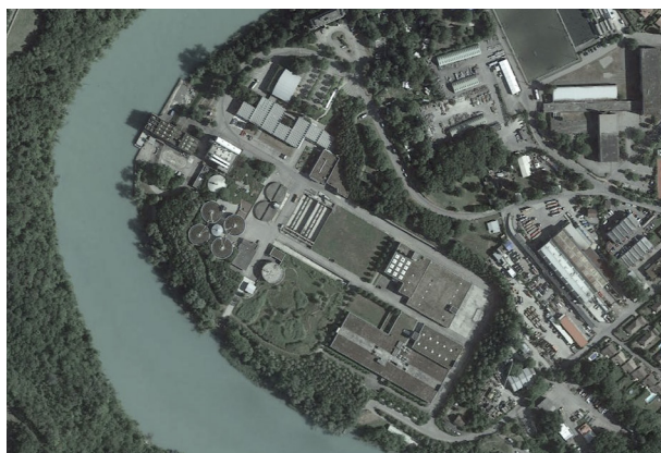
Station d'épuration d'Aire
